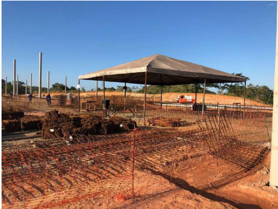
Figura 6 – Área operacional em canteiro de obra em Vitória - ES.
