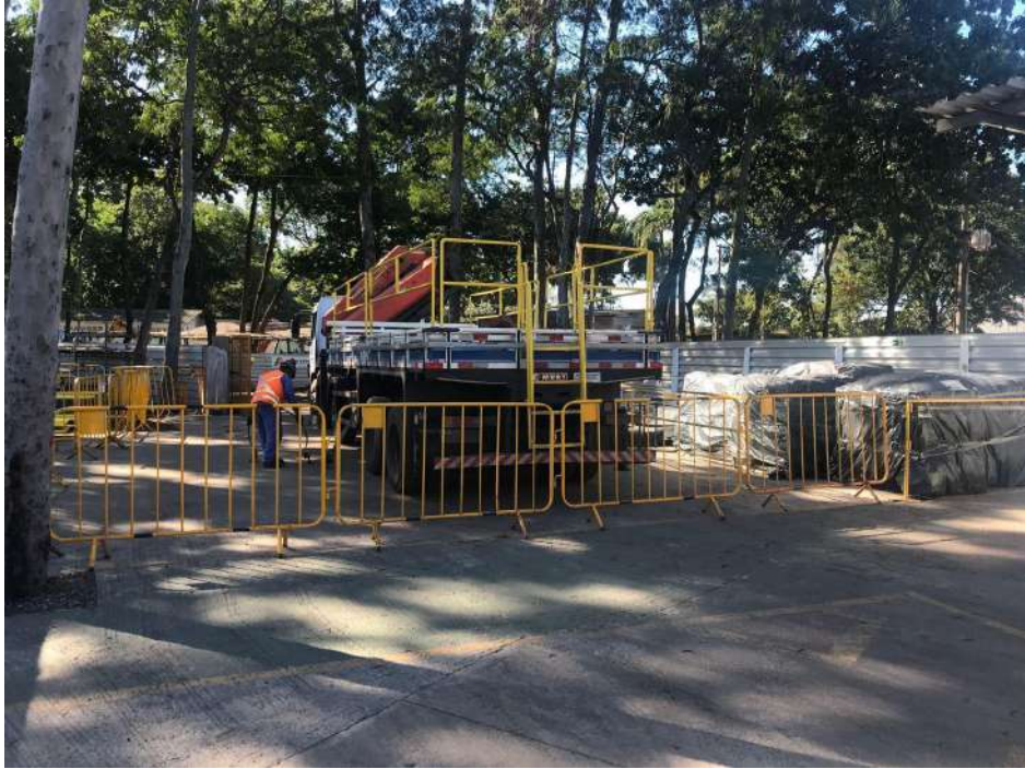
Figura 51 – Acesso dos caminhões ao canteiro.
