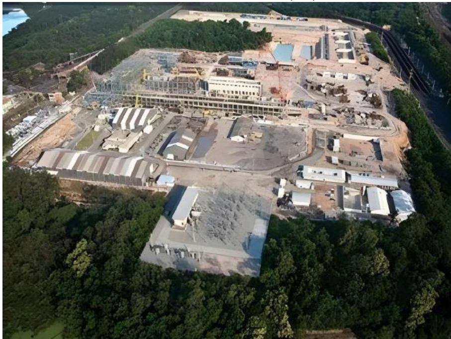
Figura 26 – Construção da oitava usina de pelletização de minério de ferro no Complexo de Tubarão, em Vitória (ES).
