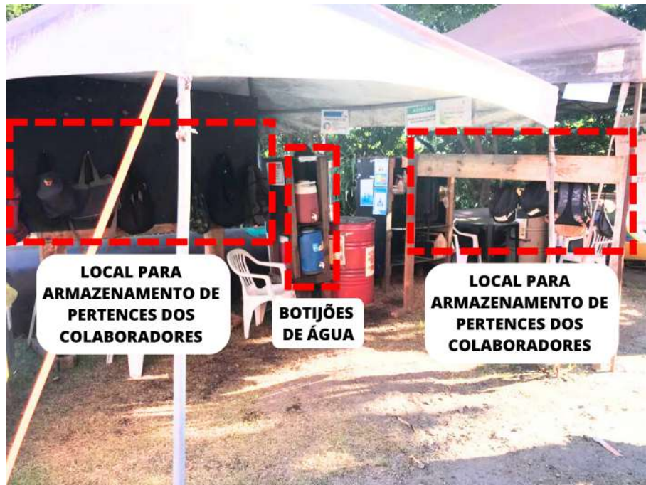
Figura 37 – Tenda para disponibilizar água e local para armazenamento de pertences aos colaboradores no local de obra.
