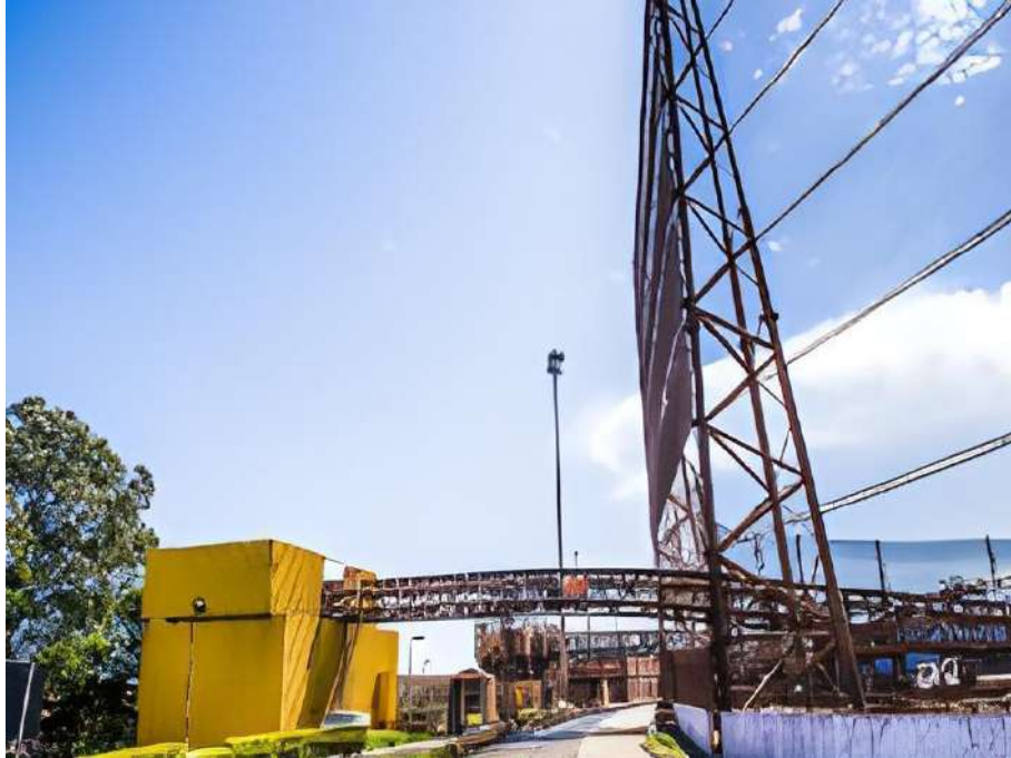
Figura 20: Casas de Transferência (CAT) de correias transportadoras de minério.
