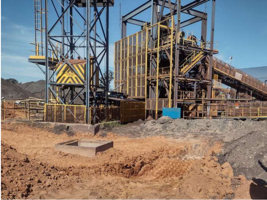
Figura 18 – Execução de fundações diretas, profundas e estruturas de concreto.
