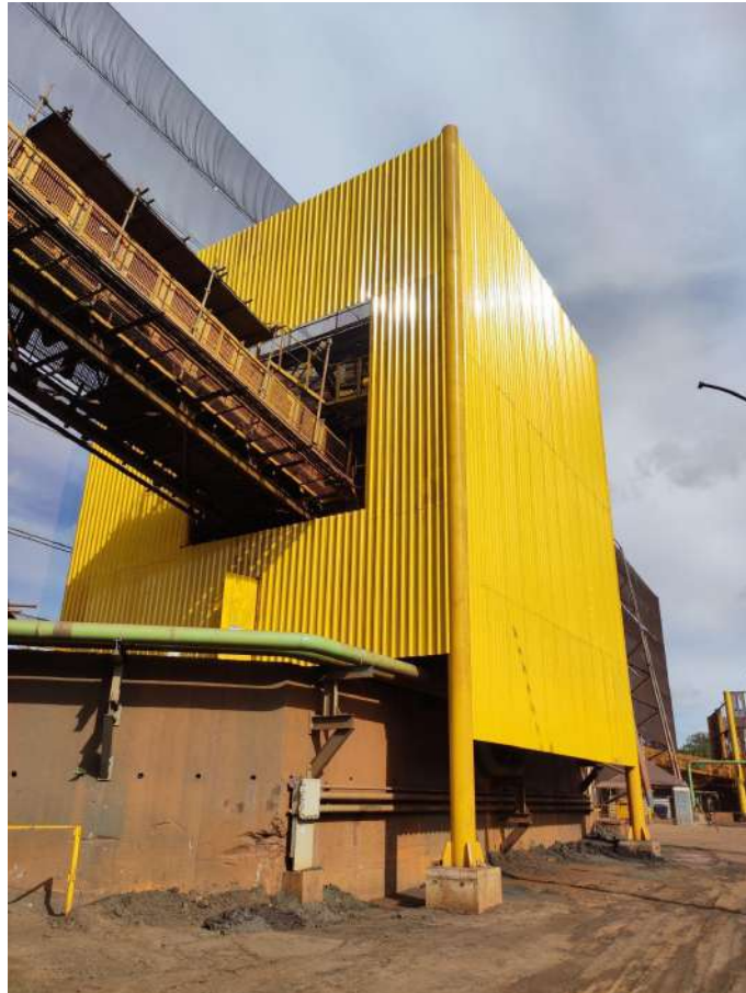
Figura 19 – Montagem de estrutura metálica e enclausuramento da estrutura com telhas metálicas.
