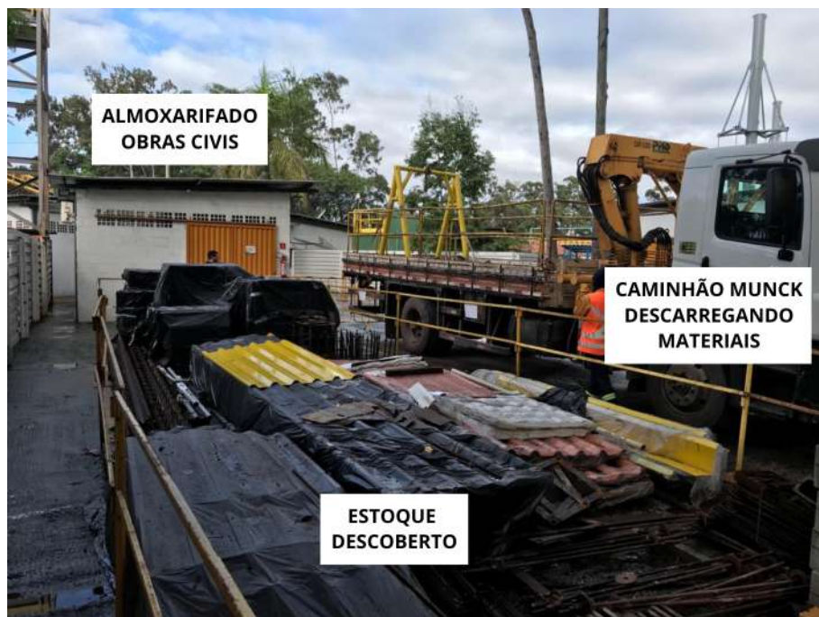
Figura 61 – Material sendo descarregado no local de armazenamento.
