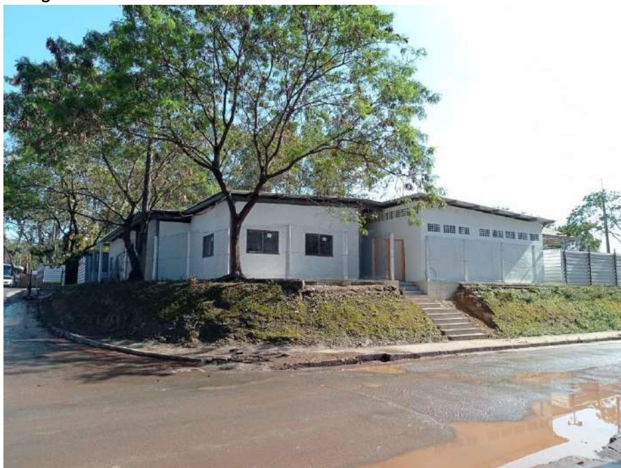
Figura 27 – Vista externa do canteiro de obras feito em alvenaria.
