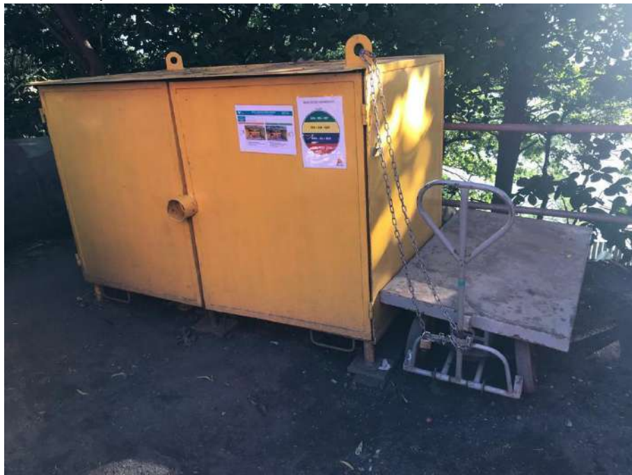
Figura 38 – “Malão” para armazenamento de ferramentas e documentos no local da obra.
