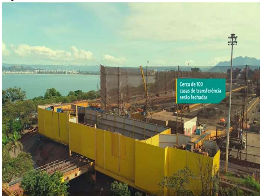
Figura 22 – Obras de fechamento de casas de transferência no PDA.
