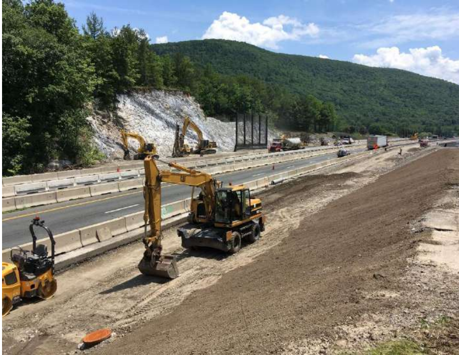
Figura 9 – Obra de reconstrução de rodovia em Massachusetts - EUA.
