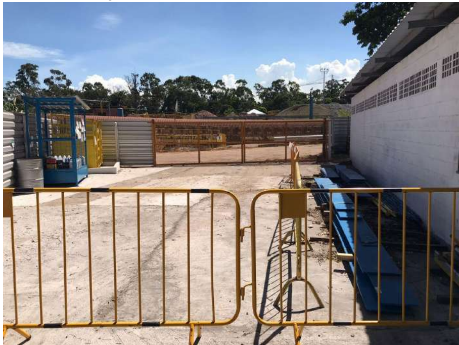
Figura 50 – Acesso de ônibus do canteiro.
