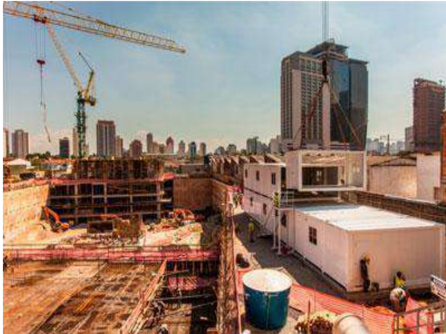
Figura 3 – Canteiro de obras atual utilizando contêiner.
