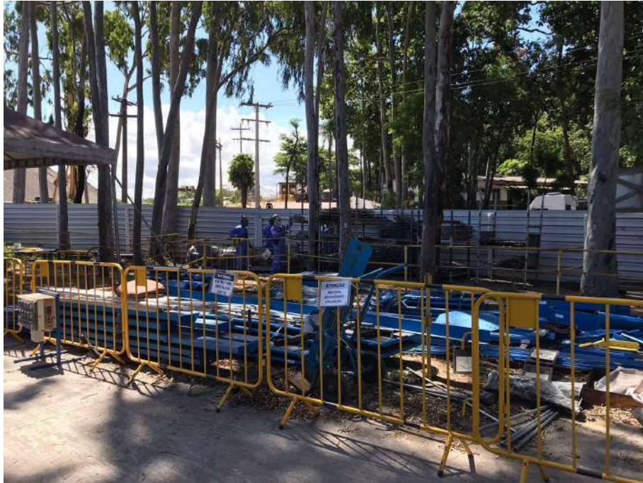
Figura 32 – Estoque descoberto para peças de estruturas metálicas de dimensões grandes e, portanto, não cabem dentro do almoxarifado.
