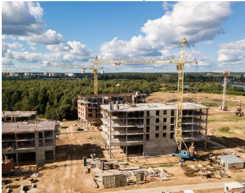
Figura 10 – Canteiro de obras em construção de condomínio residencial.
