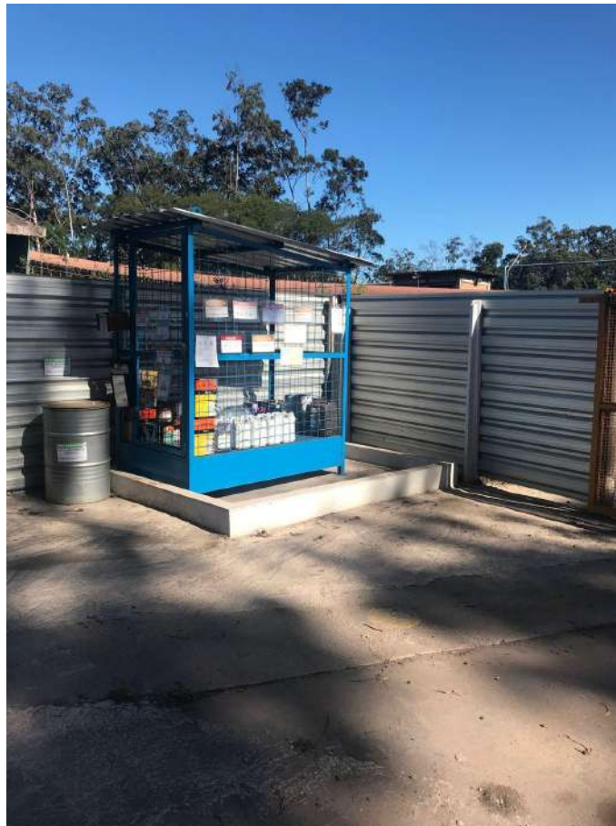
Figura 52 – Armazenamento de produtos químicos no canteiro.
