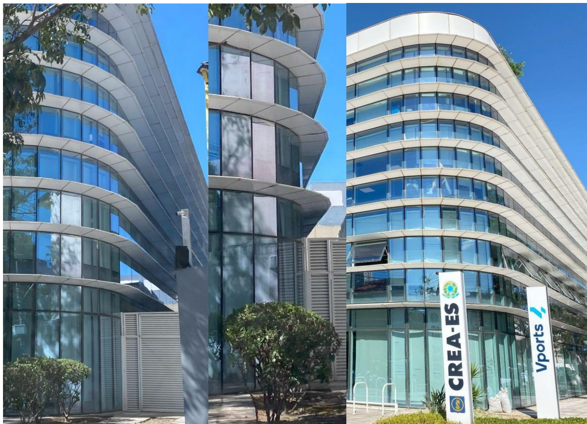
Figura 16 - Detalhes da fachada do edifício - Brises.
