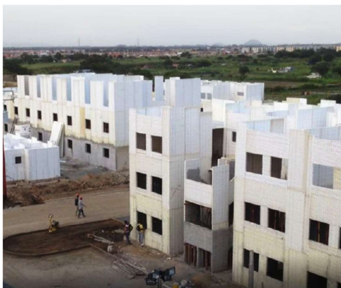
Figura 36 – Exemplo de edificação com painéis de EPS
