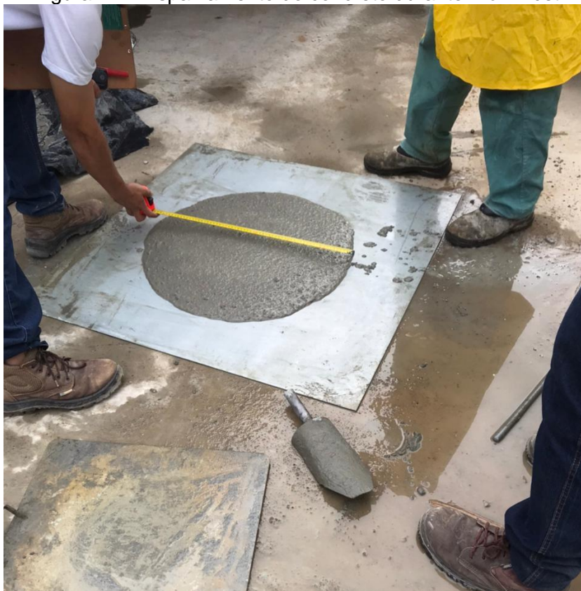
Figura 11 – Espalhamento do concreto durante Flow Test
