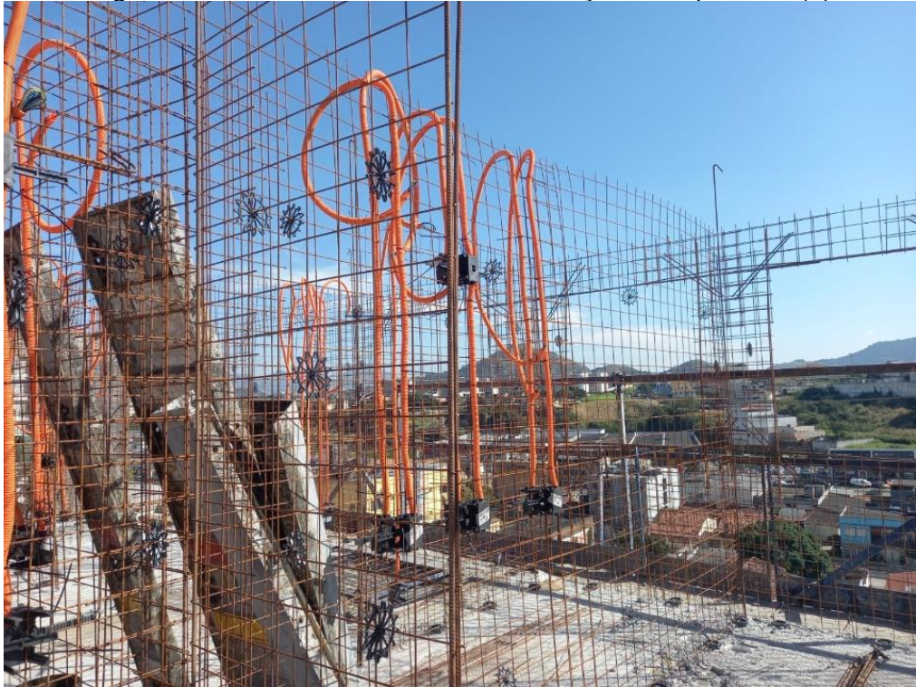
Figura 18 – Vista das armaduras e instalações das paredes (1)
