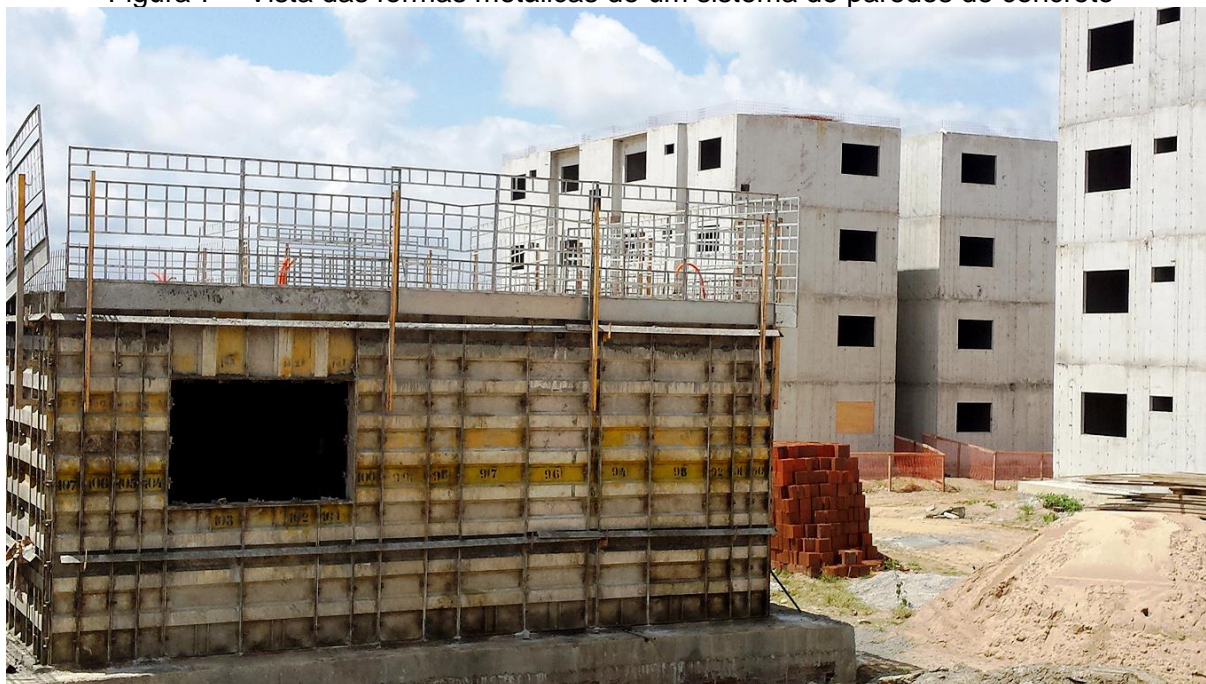
Figura 7 – Vista das formas metálicas de um sistema de paredes de concreto
