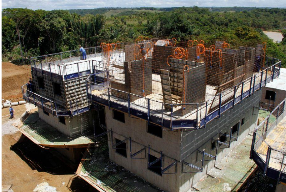
Figura 6 – Posicionamento das instalações e montagem das formas
