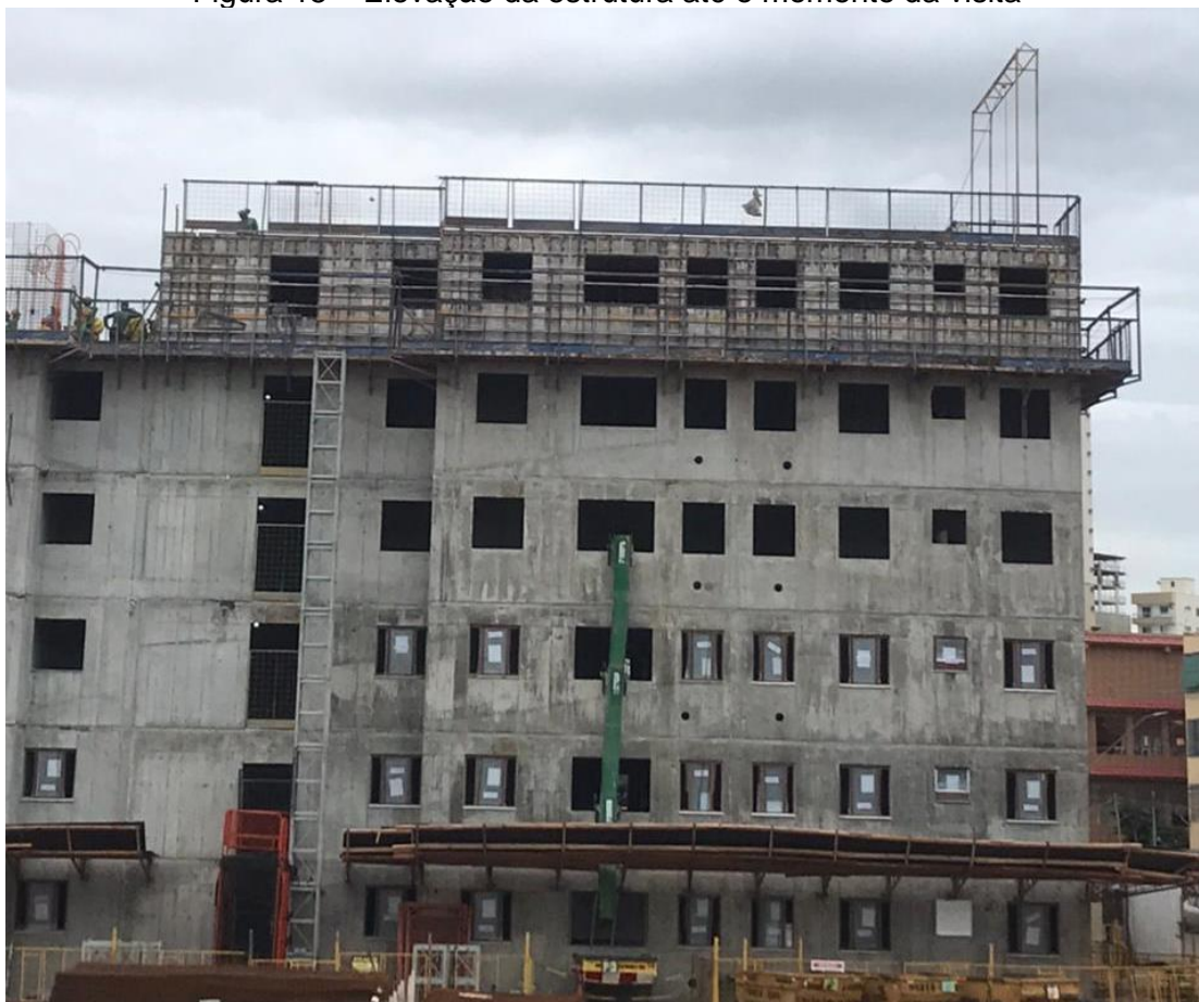
Figura 15 – Elevação da estrutura até o momento da visita
