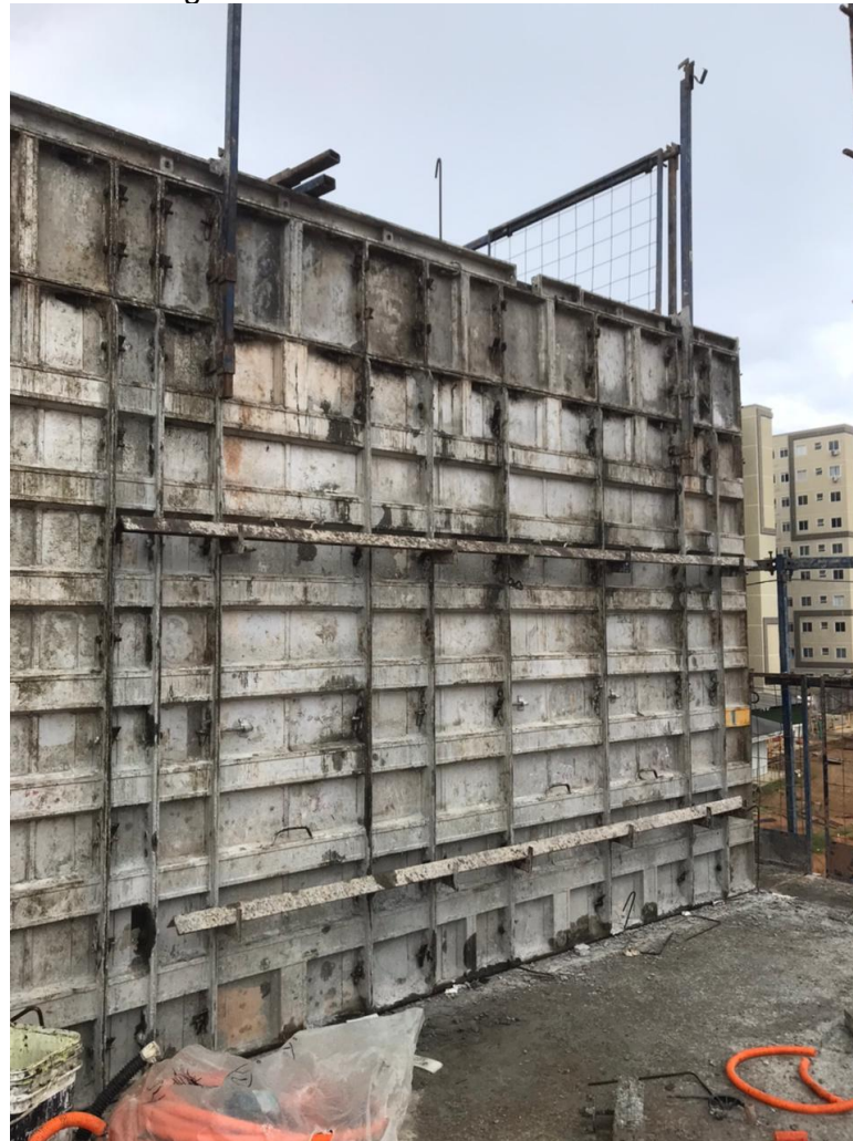
Figura 17 – Vista das formas metálicas
