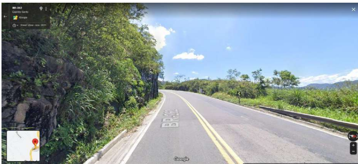
Figura 30 - Imagem de codificação do segmento de distância 1,6, localizado no km 34,6.
