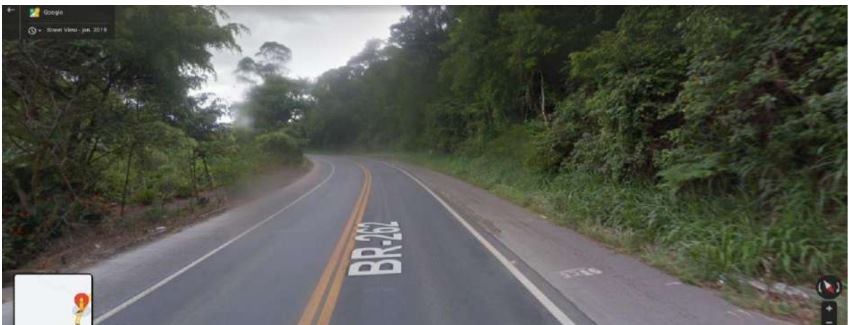
Figura 32 - Imagem de codificação do segmento de distância 2,1, localizado no km 44,1
