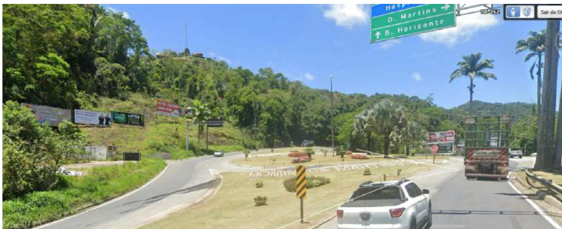
Figura 19 - Canteiro Central na Rotatória - Segmento 4,5
