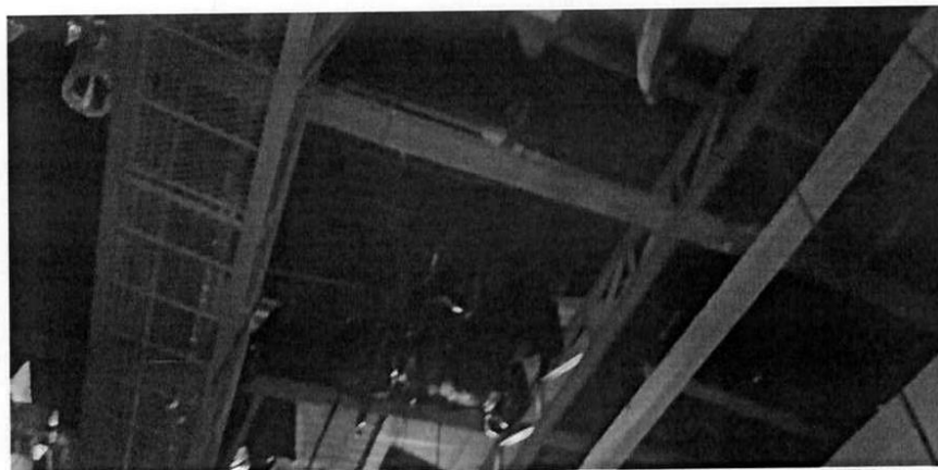
Foto 11 – Estrutura metálica – necessita tratamento contra corrosão
