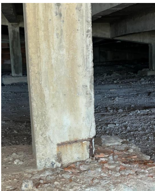
Figura 42 – Oxidação no pilar
