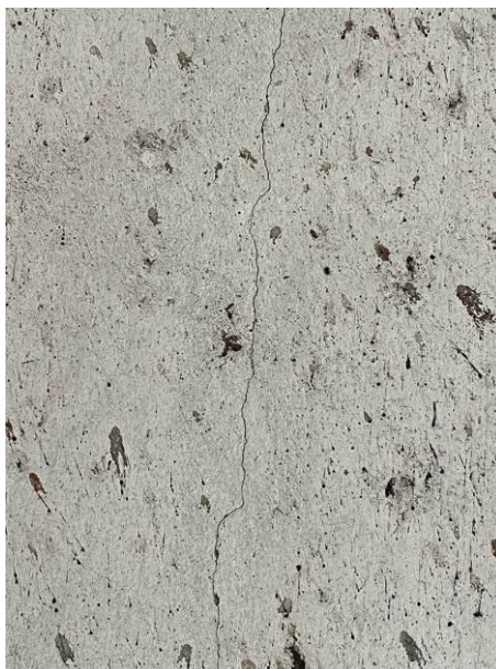
Figura 37– Trincas na parede de concreto inclinada
