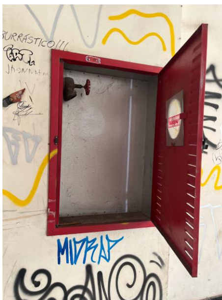
Figura 65 – Hidrante de parede instalado no Foyer
