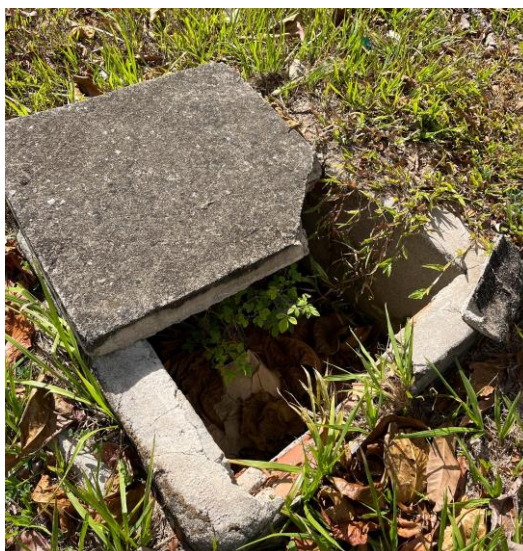
Figura 60 – Caixa de inspeção danificada
