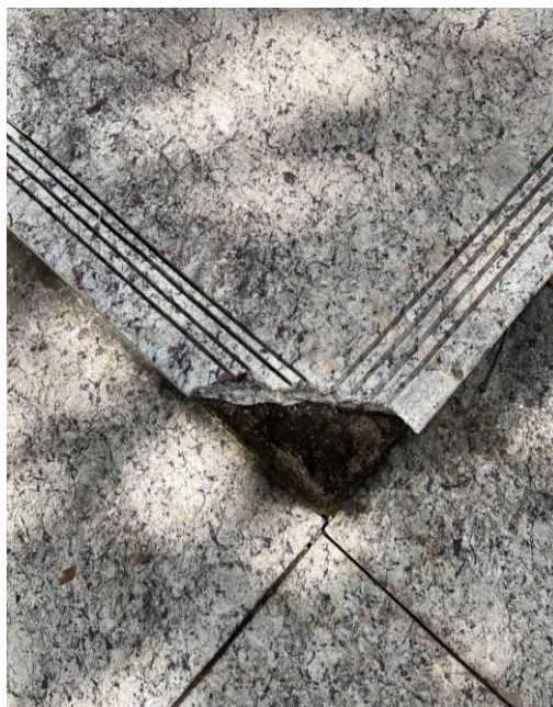
Figura 89 – Revestimento de granito do foyer quebrado
