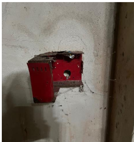
Figura 67 – Caixa do alarme de incêndio depredada
