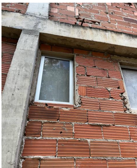
Figura 84 – Ausência de verga e contraverga
