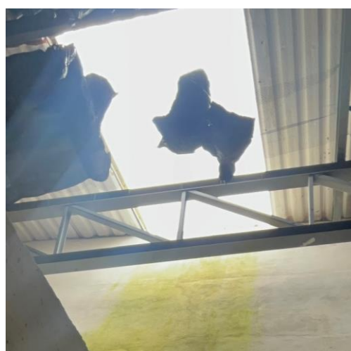
Figura 71 – Ausência de telhas na cobertura
