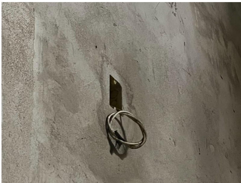
Figura 48 – Instalações embutidas na parede
