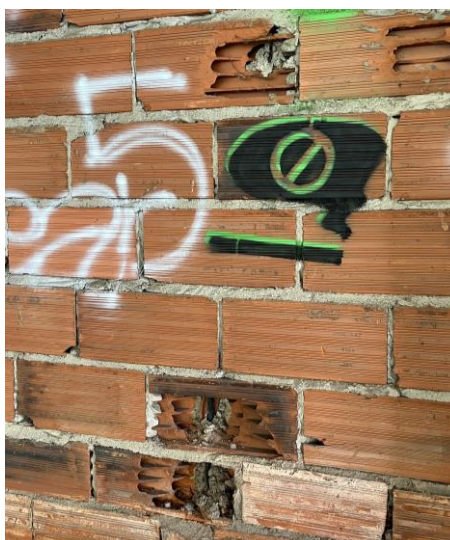
Figura 77– Blocos cerâmicos danificados
