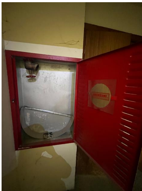
Figura 64 – Hidrante de parede instalado no 2º pavimento
