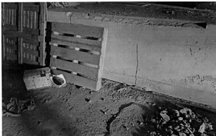
Figura 27: Elementos Estruturais com Trincas
