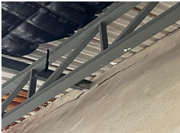
Figura 70 – Trinca na alvenaria no local onde foi apoiada a estrutura metálica da cobertura
