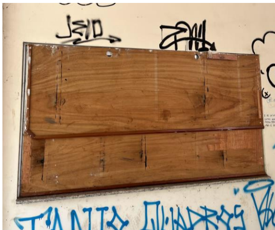
Figura 85 – Proteção de madeira devido a esquadria danificada
