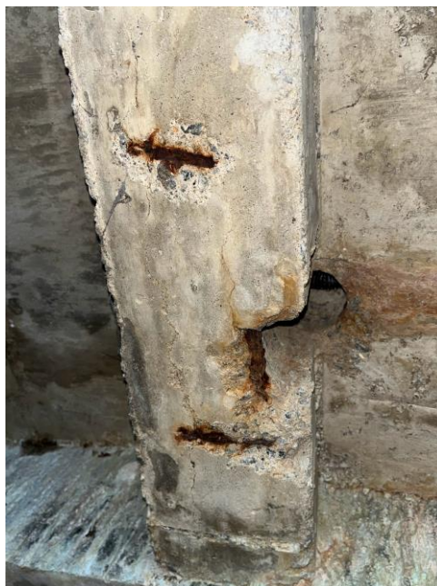
Figura 43 – Oxidação na armadura da viga
