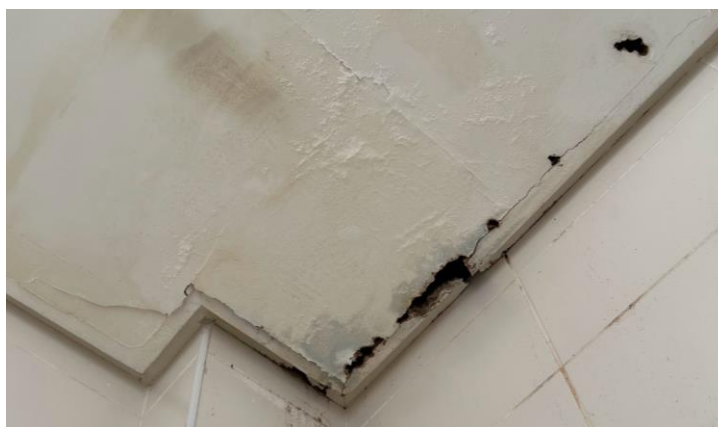
Figura 80– Infiltração no forro de gesso do banheiro
