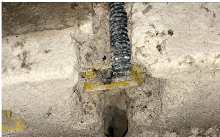
Figura 51– Comprometimento na qualidade do conduíte em decorrência de execução inadequada
