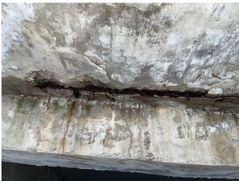
Figura 44 – Oxidação na armadura da laje
