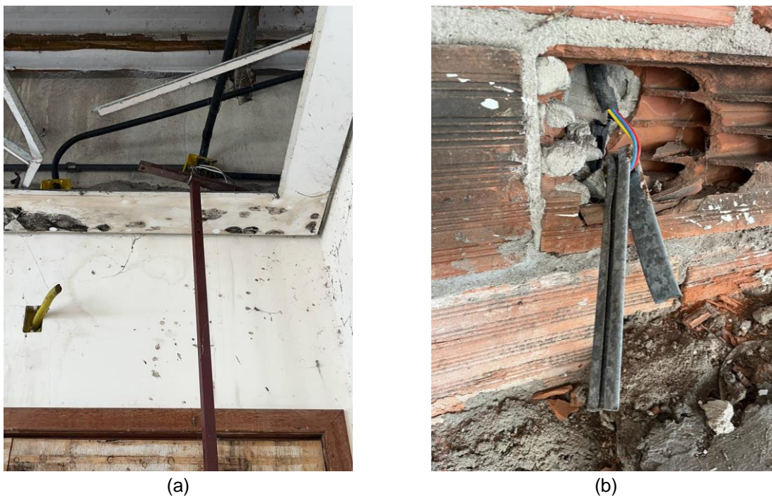
Figura 30 – Instrumentos de aço utilizados para retirada da fiação elétrica instalada
