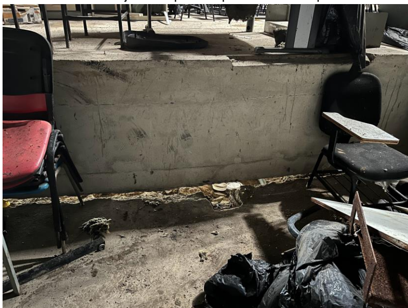
Figura 39 – Afundamento da laje entre palco e plateia visto da parte interna da edificação
