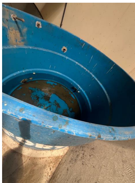
Figura 61 – Acúmulo de água e resíduos na caixa d'água
