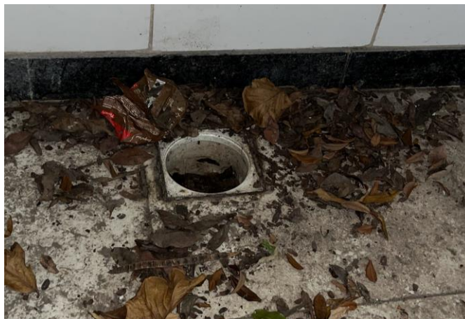
Figura 57 – Ausência de proteção no ralo
