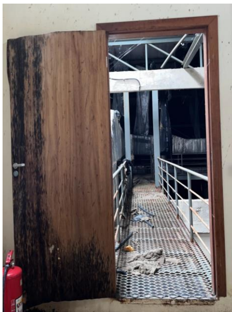
Figura 82 – Porta do acesso as passarelas apresentando mofo devido às infiltrações
