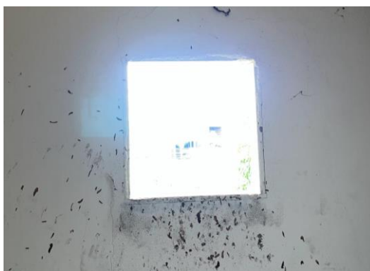
Figura 86 – Ausência de esquadria na área técnica do 2º pavimento
