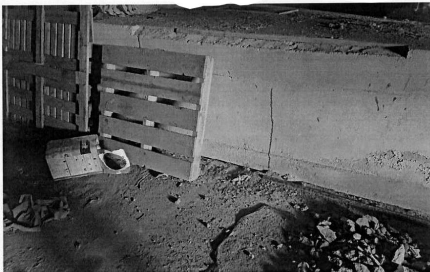
Foto 12 – Recalque piso
