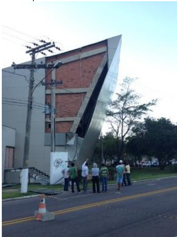
Figura 21 – Desplacamento do revestimento de ACM da fachada
