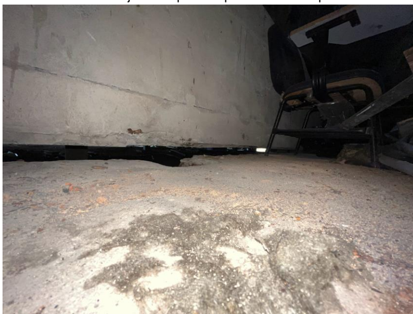
Figura 40 – Afundamento da laje entre palco e plateia visto da parte interna da edificação
