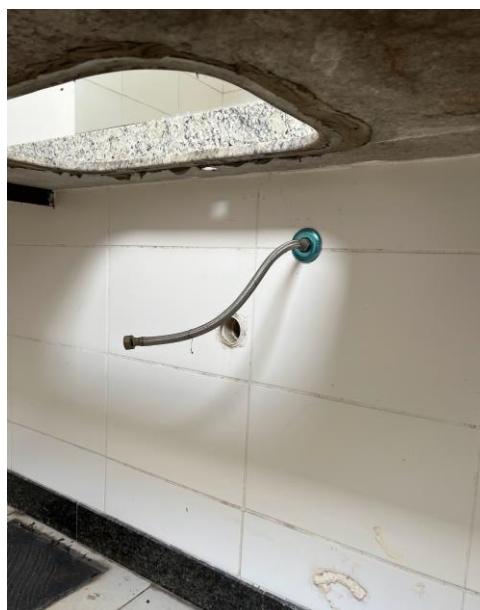
Figura 56 – Retirada da pia e de itens hidrossanitários
