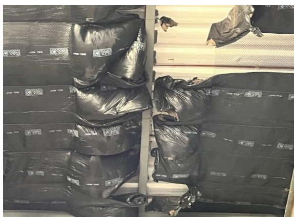
(a) Lãs de rocha ensacadas absorvendo umidade
