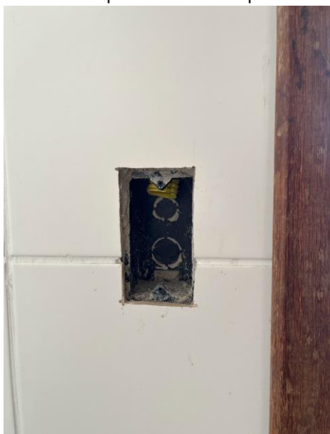
Figura 52 – Ausência de espelhos no interruptor do banheiro feminino
