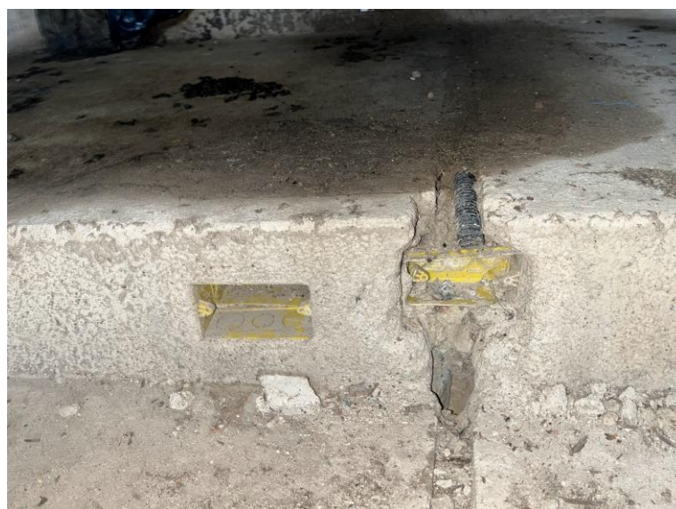
Figura 49 – Instalações embutidas na laje de piso
