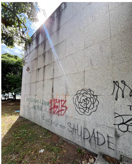
Figura 88 – Revestimento de granito da fachada com pichações
