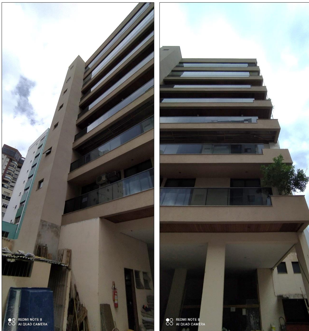
Figura 35 - Fachada dos fundos do Edifício A finalizada.
