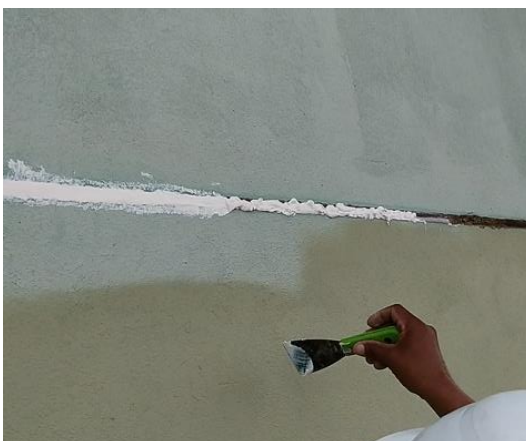
Figura 59 - Etapa de acabamento da junta de movimentação do Edifício B realizado com espátula.
