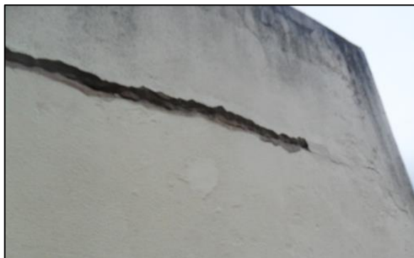
Figura 42 - Corrosão da armadura ao longo de toda a fachada do Edifício A.
