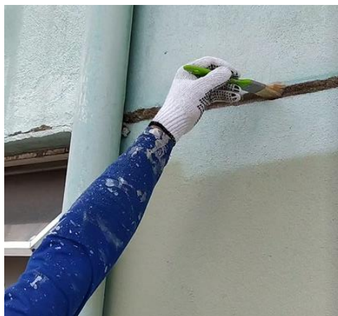
Figura 55 - Etapa de limpeza do local com auxílio de pincel em junta do Edifício B.
