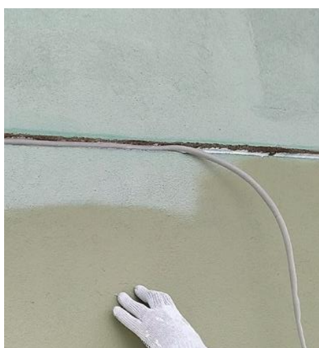
Figura 57 - Etapa de posicionamento manual do tarucel em junta de movimentação do Edifício B.
