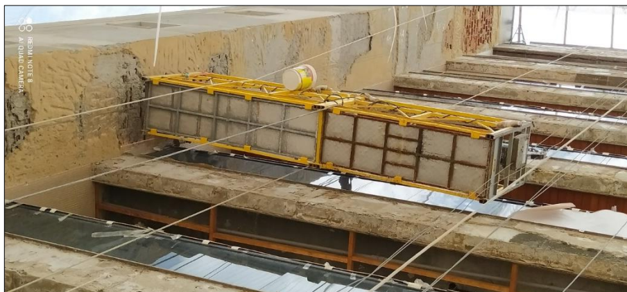
Figura 33 - Fachada dos fundos durante reforma do Edifício A, com destaque para andaime utilizado.
