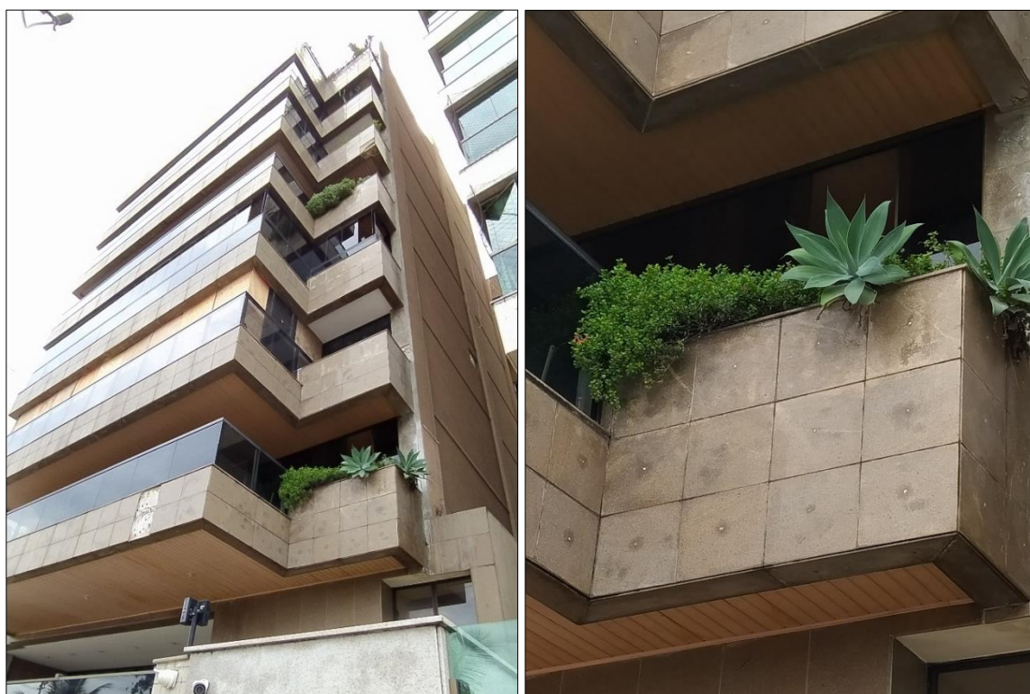
Figura 15 - Fachada frontal do Edifício A com revestimento parafusado.
