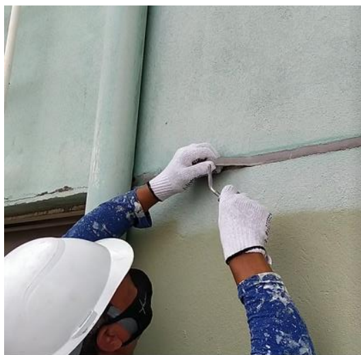
Figura 53 - Etapa de remoção de junta existente no Edifício B.
