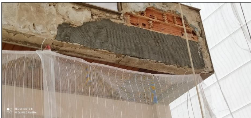
Figura 45 - Terapia da viga na fachada dos fundos do Edifício A.
