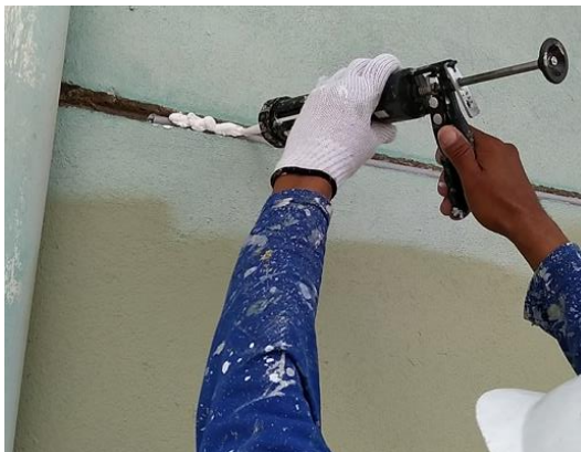
Figura 58 - Etapa de preenchimento da junta de movimentação do Edifício B com selante.
