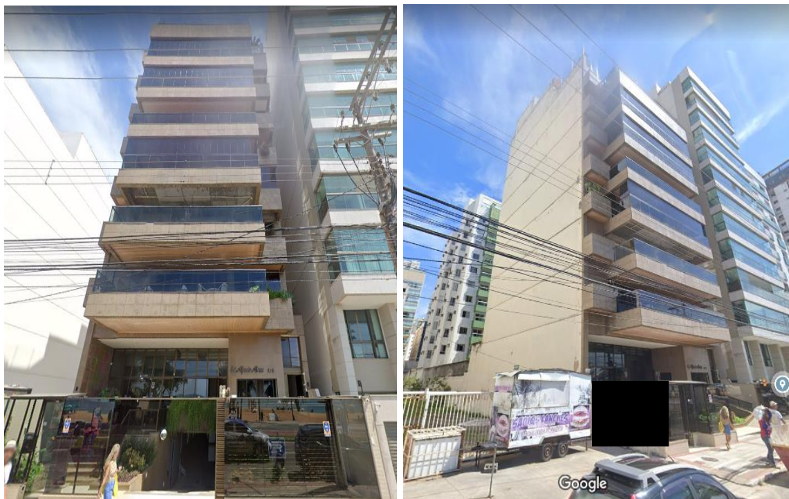
Figura 9 - Vista frontal do Edifício A.
