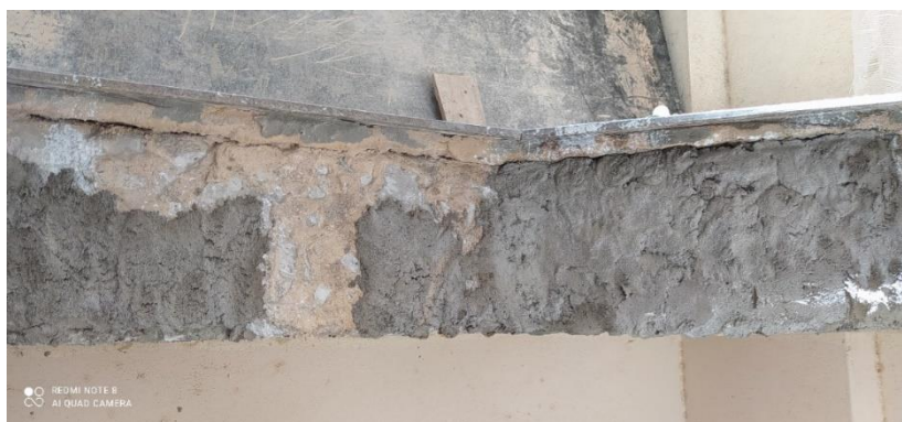
Figura 46 - Terapia da viga devido à corrosão do Edifício A.
