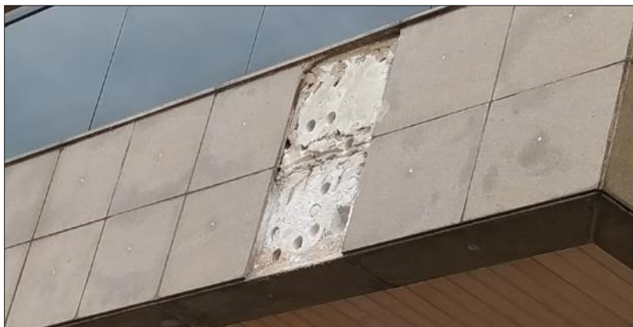
Figura 31 - Local de retirada dos corpos de prova para ensaio de arrancamento do Edifício A.
