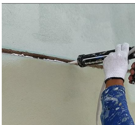
Figura 56 - Etapa de aplicação de fina camada de selante com auxílio de pistola em junta de movimentação do Edifício B.
