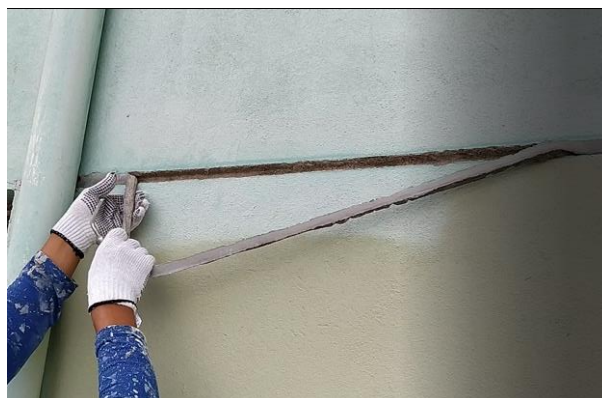
Figura 54 - Auxílio de ferramenta “unha de gato” para remoção de junta existente no Edifício B.
