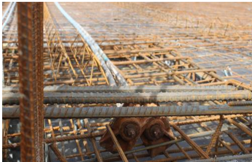
Figura 2-22 - Ancoragem com cunhas de aço
