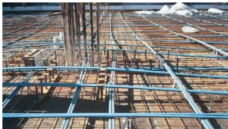
Figura 2-20 - Cordoalhas engraxadas dispostas em uma laje
