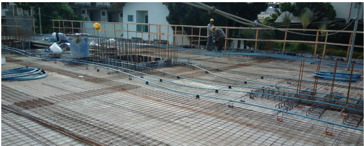
Figura 2-15 - Montagem de laje protendida. Edifício Trento, Jardim Camburi, Vitória - ES
