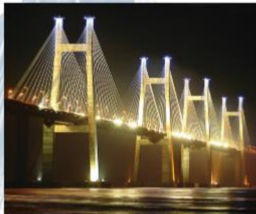
Ponte sobre o Rio Orinoco Puerto Ordaz - Venezuela
