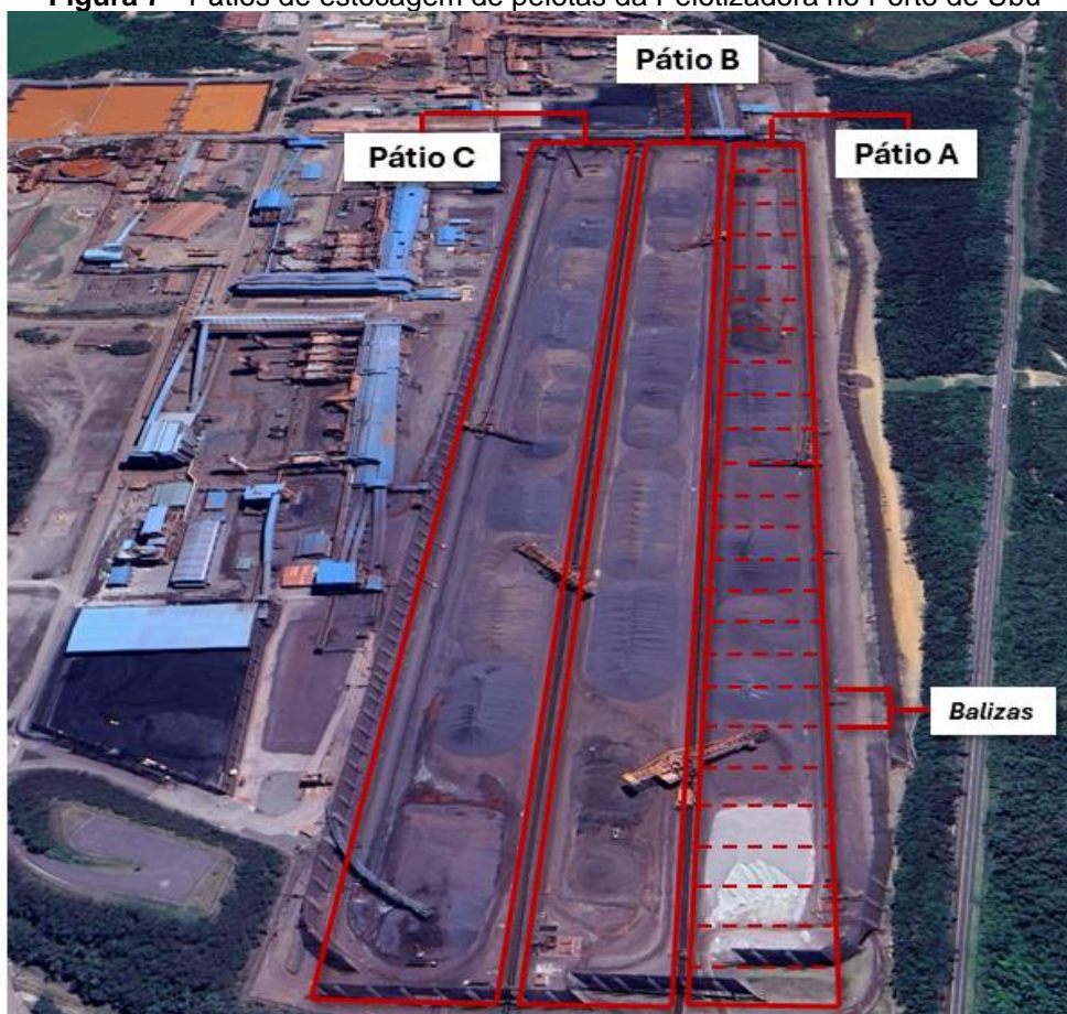
Figura 7 - Pátios de estocagem de pelotas da Pelotizadora no Porto de Ubu
