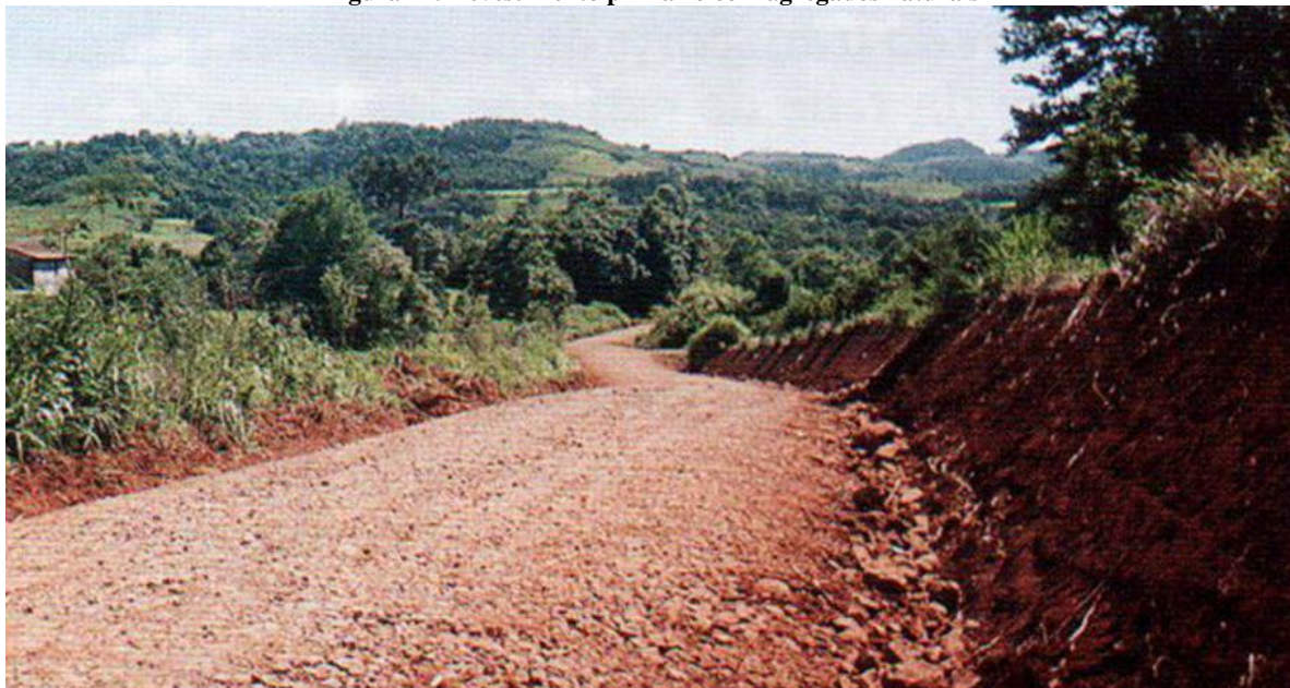
Figura 14: Revestimento primário com agregados naturais
