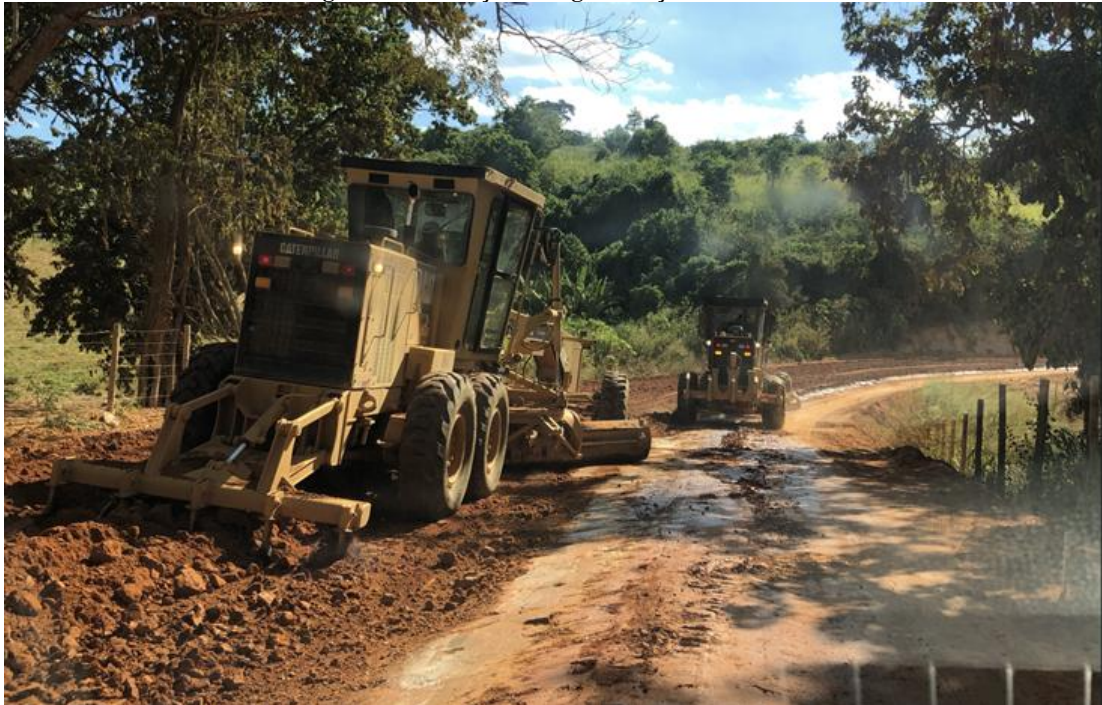
Figura 12: Execução de regularização de subleito
