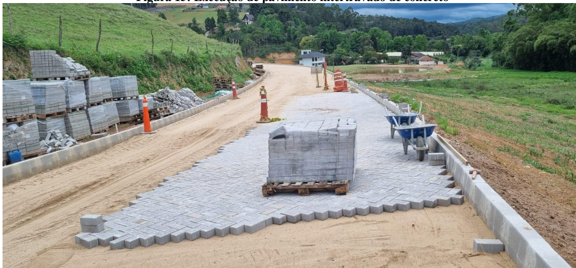
Figura 15: Execução de pavimento intertravado de concreto
