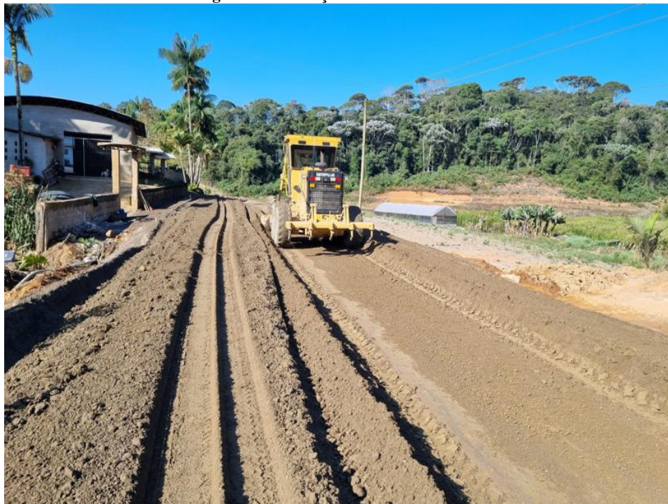
Figura 13: Execução de camada de base
