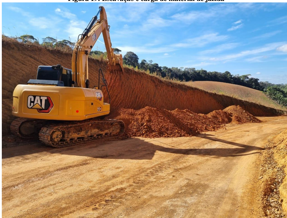
Figura 19: Escavação e carga de material de jazida
