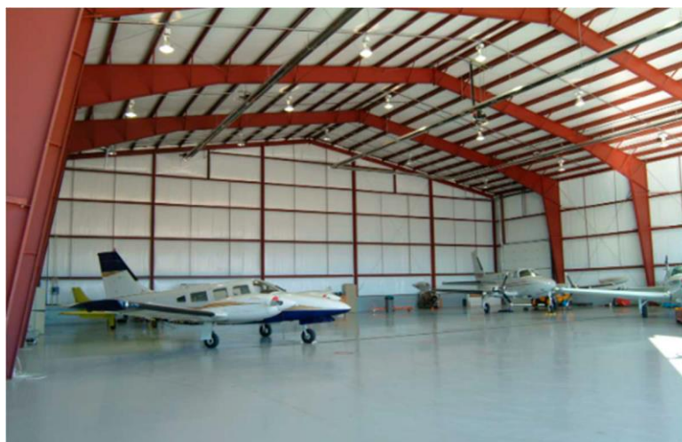
Figura 1 - Galpão de aeronaves construído com perfis de inércia variável pela R & M Steel Company
