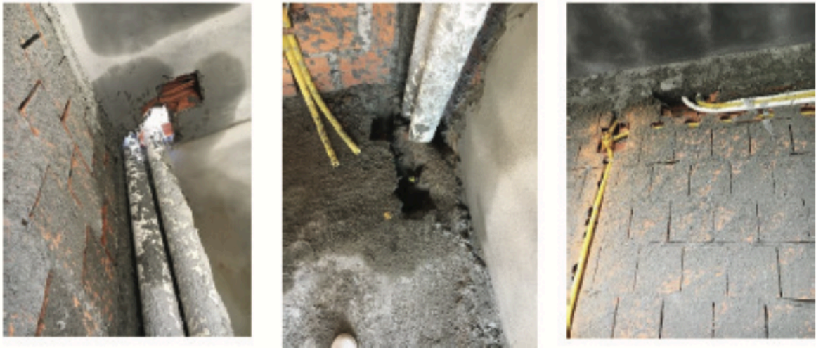
Figura 11 - Interferência entre as disciplinas em canteiro de obras: furo na laje e furo na viga para tubulações
