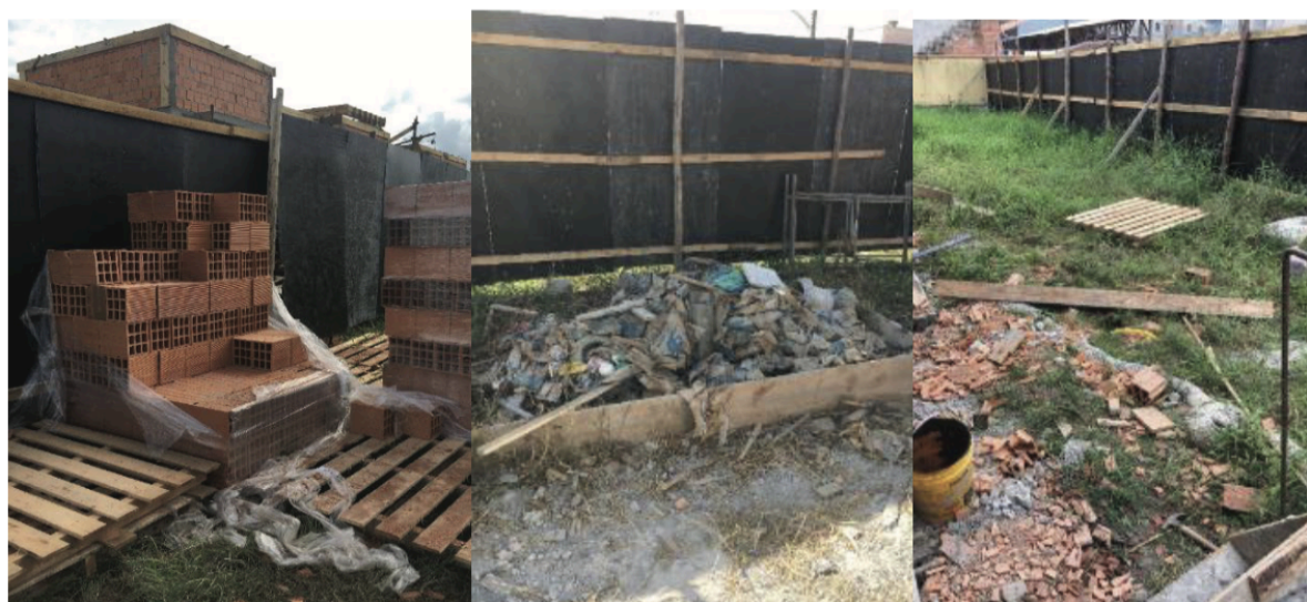
Figura 12 - Armazenamento/organização dos blocos cerâmicos e resíduos do canteiro de obras
