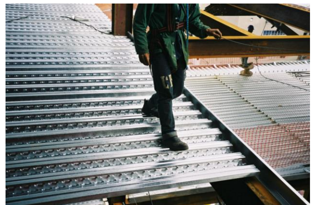
Figura 17: Mossas das fôrmas metálicas
