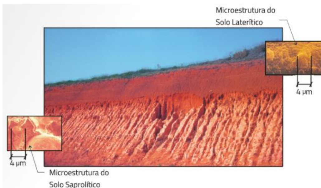
Figura 13 - Corte rodoviário, com camada laterítica sobrejacente à camada saprolítica de origem sedimentar, com as correspondentes microestruturas
