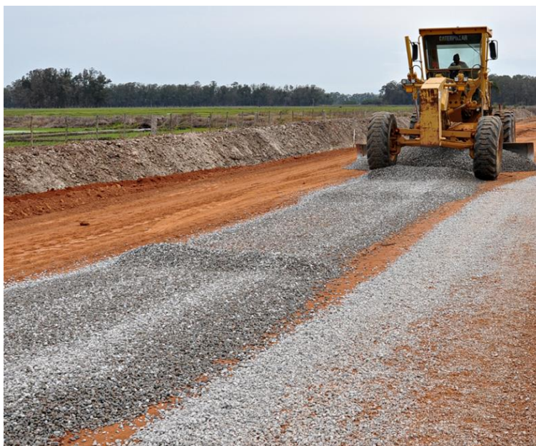
Figura 4 - Estabilização granulométrica com brita graduada simples
