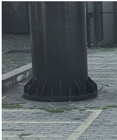
Figura 12 – Enrijecedores aplicados em perfis circulares
