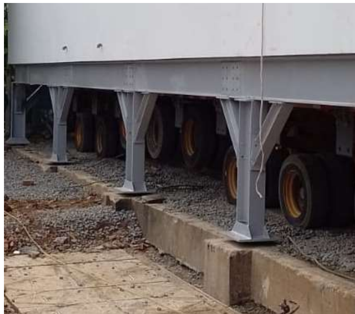
Figura 10 – Projeto executado de placa de base
