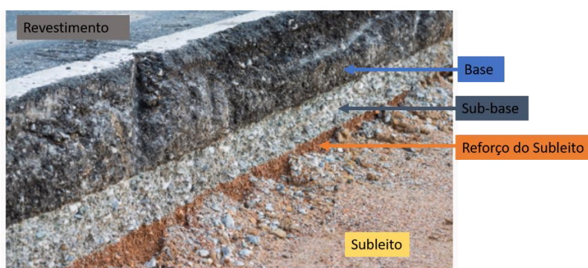
Figura 2.5 – Estrutura real de um pavimento flexível
