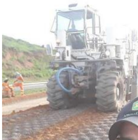
Figura 3.8 – Máquina recicladora utilizada no espalhamento e homogeneização das misturas de solo com KR e solo com cimento
