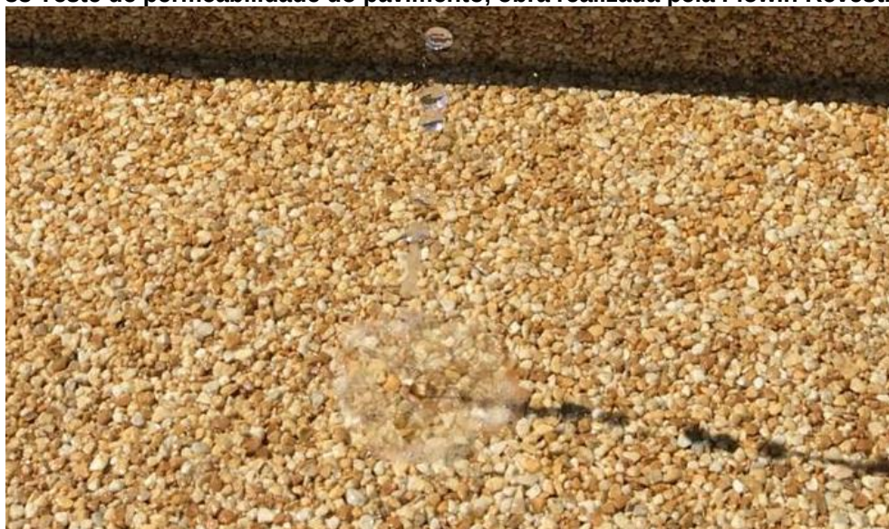
Figura 33 Teste de permeabilidade do pavimento, obra realizada pela Flowin Revestimentos
