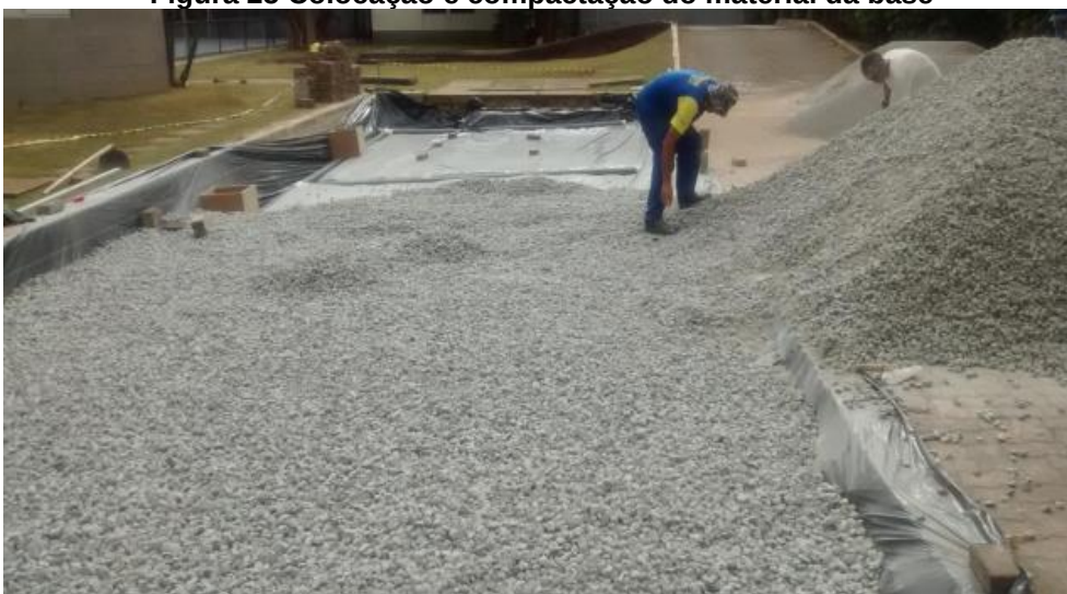
Figura 25 Colocação e compactação do material da base
