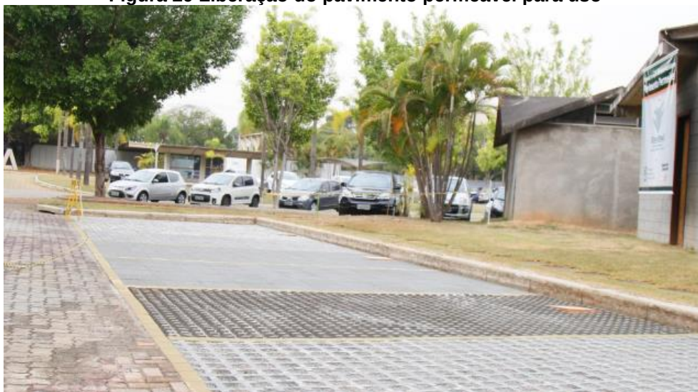
Figura 29 Liberação do pavimento permeável para uso
