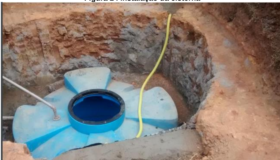
Figura 24 Instalação da cisterna
