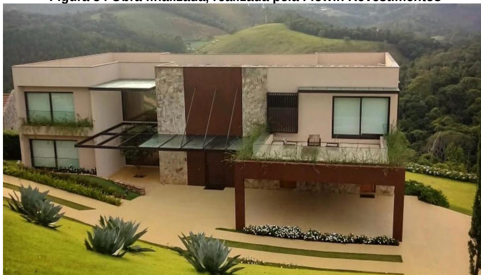
Figura 34 Obra finalizada, realizada pela Flowin Revestimentos
