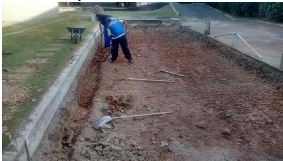
Figura 20 Abertura das valas dos drenos
