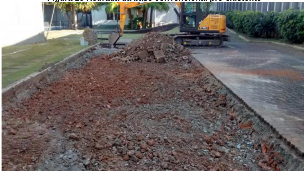
Figura 19 Retirada da base convencional pré-existente
