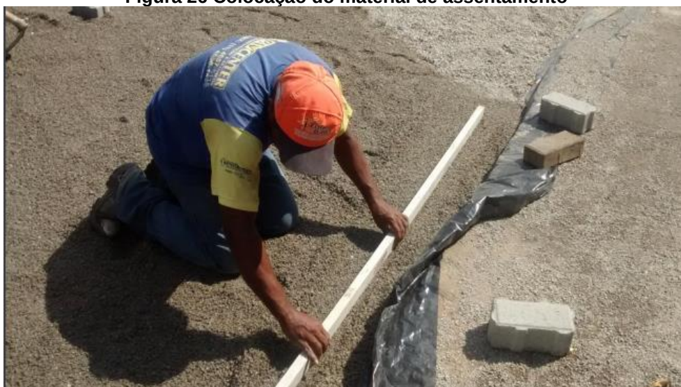
Figura 26 Colocação do material de assentamento
