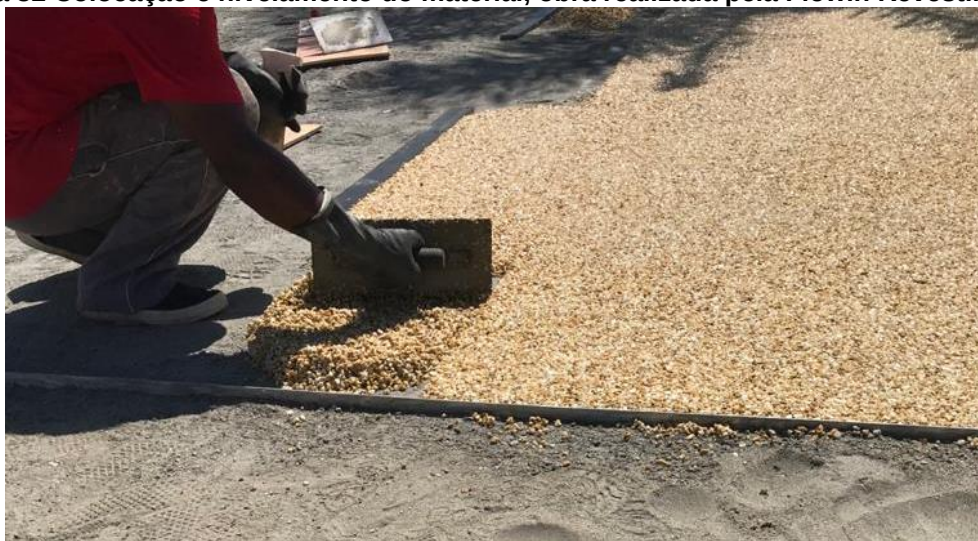
Figura 32 Colocação e nivelamento do material, obra realizada pela Flowin Revestimentos
