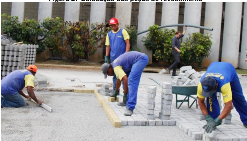
Figura 27 Colocação das peças de revestimento
