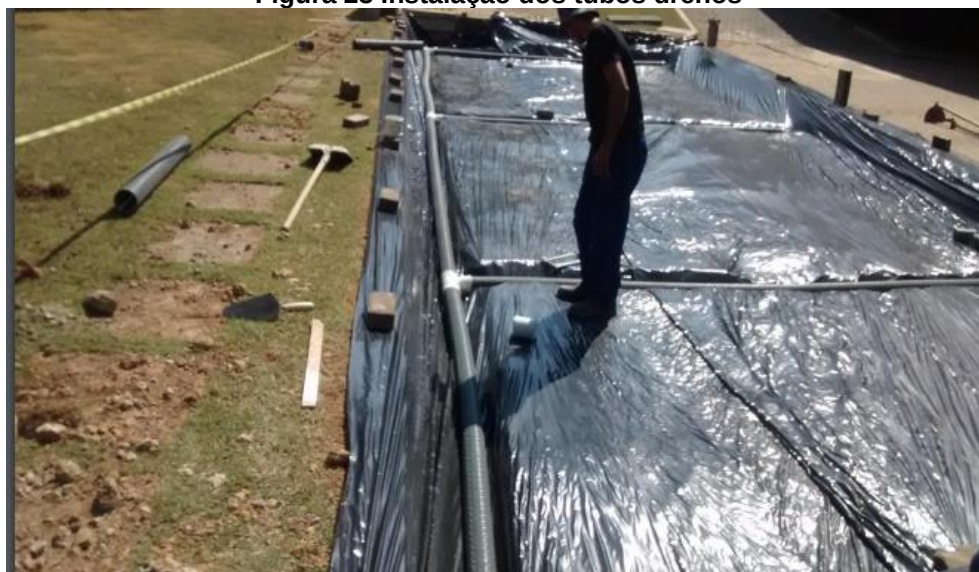
Figura 23 Instalação dos tubos drenos
