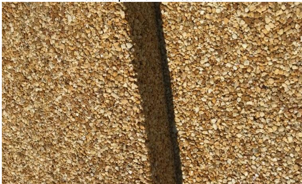
Figura 14 Pavimento permeável constituído de piso monolítico drenante - Desert 2, obra realizada pela Flowin Revestimentos.
