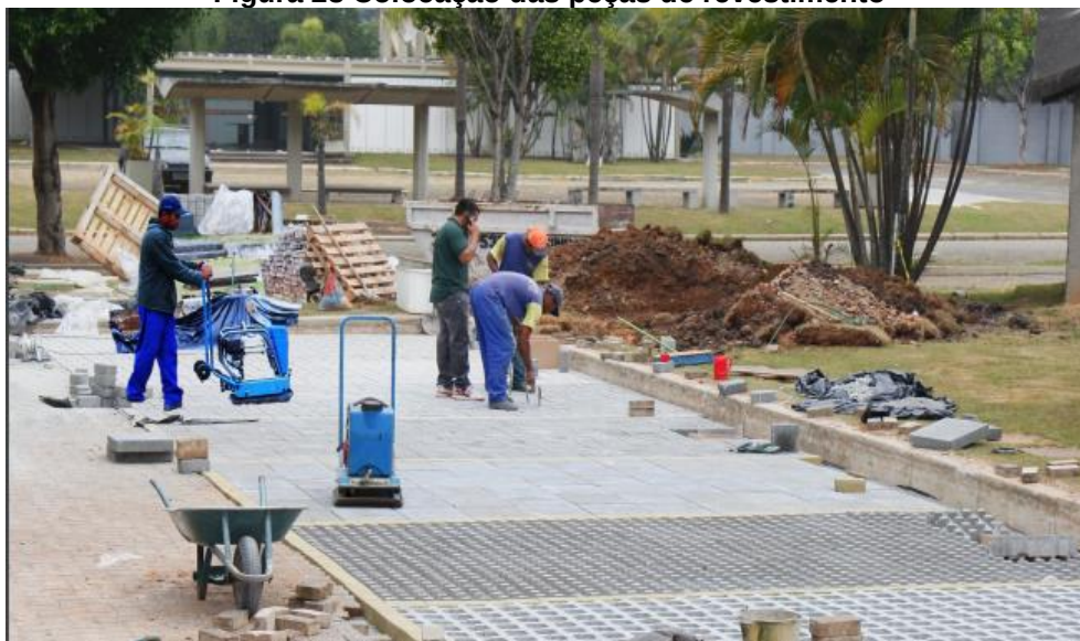
Figura 28 Colocação das peças de revestimento
