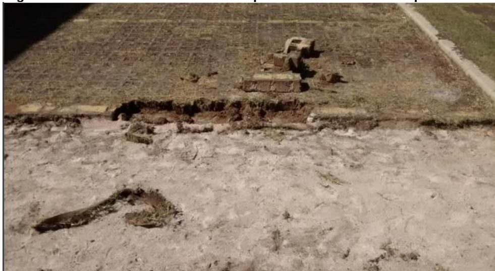
Figura 18 Retirada do revestimento do pavimento convencional pré-existente
