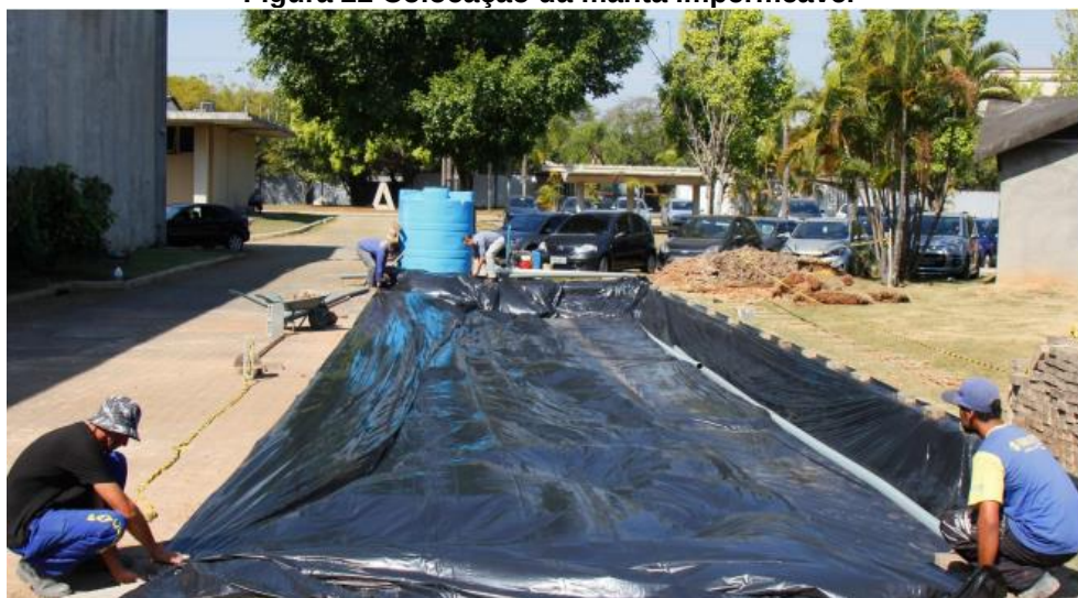
Figura 22 Colocação da manta impermeável
