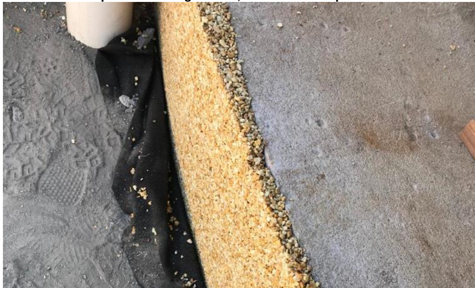
Figura 30 Solo compactado com geotêxtil, obra realizada pela Flowin Revestimentos
