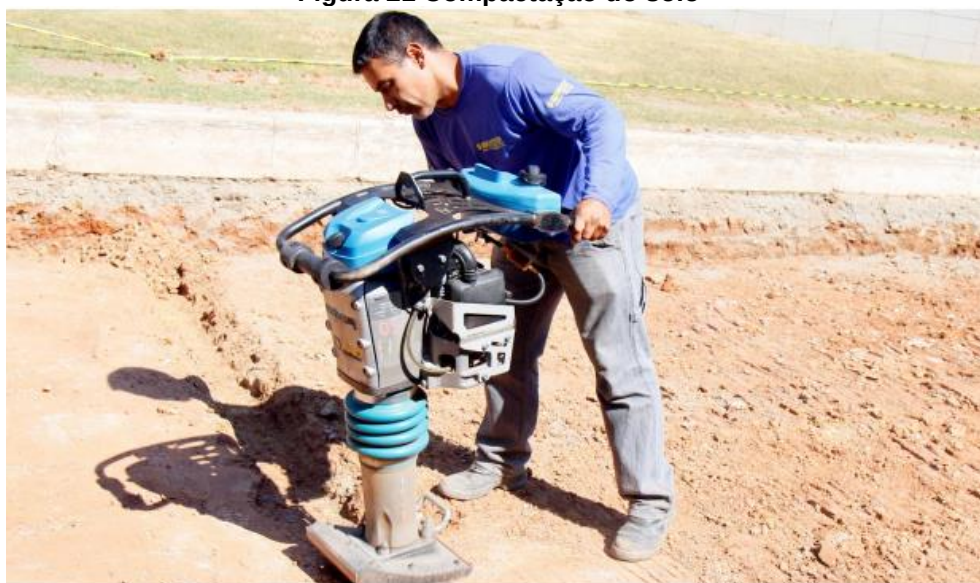
Figura 21 Compactação do solo
