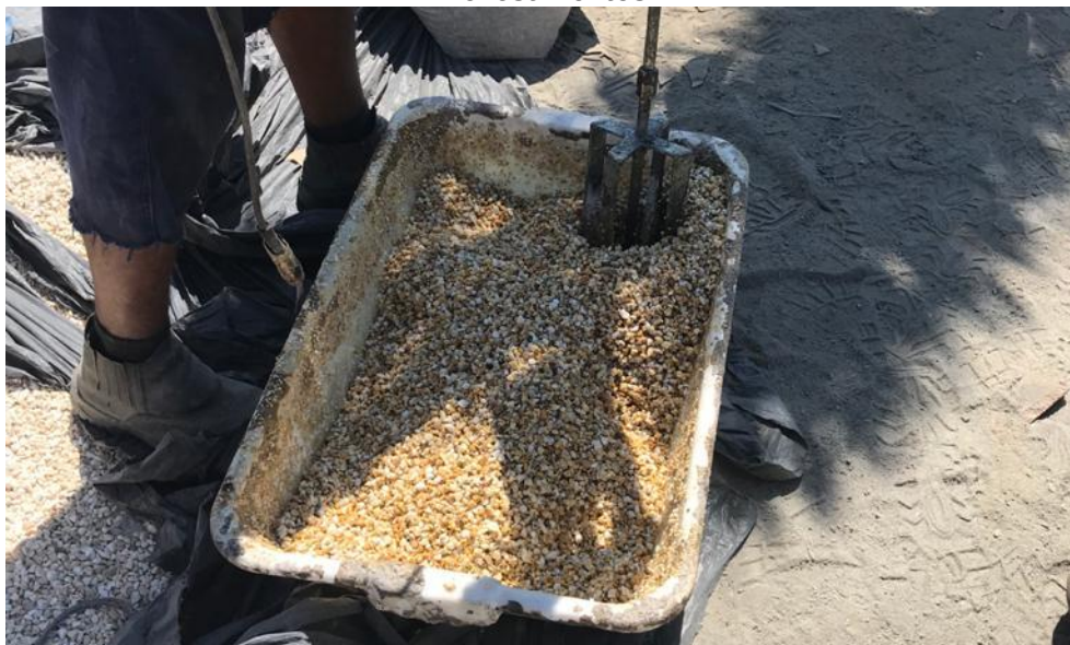
Figura 31 Mistura do agregado graúdo com base epóxi, obra realizada pela Flowin Revestimentos
