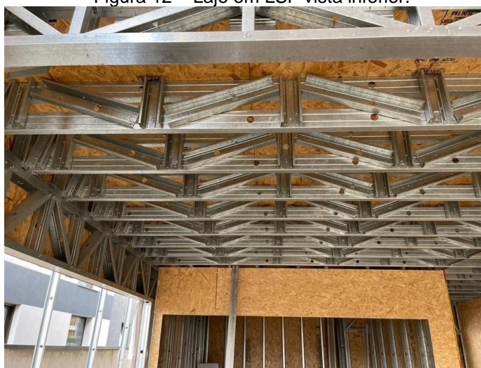
Figura 12 – Laje em LSF vista inferior.
