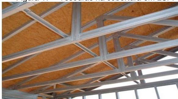
Figura 17 – Tesouras na cobertura em LSF.
