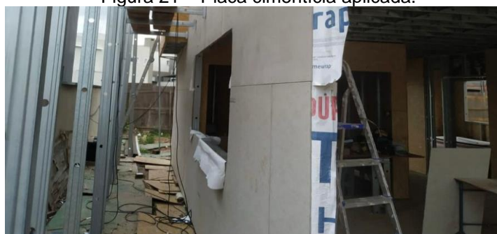
Figura 21 – Placa cimentícia aplicada.
