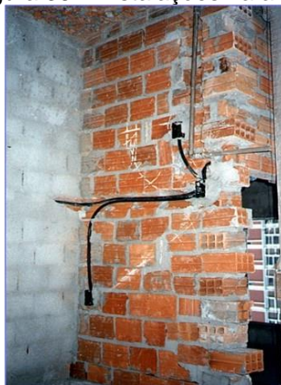
Figura 36 – Instalações na alvenaria.
