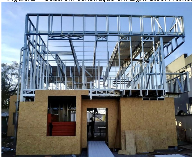
Figura 2 – Casa em construção em Light Steel Frame .
