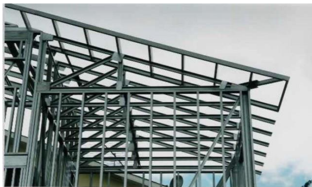
Figura 16 – Estrutura de cobertura em LSF.
