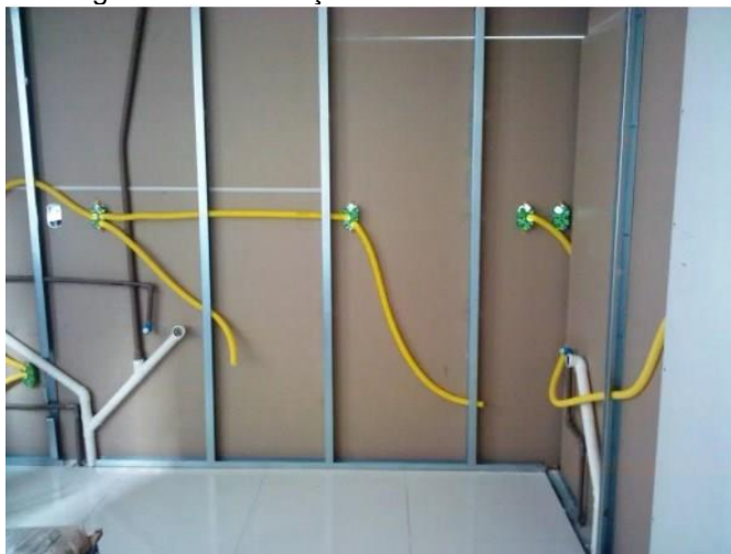
Figura 24 – Instalação elétrica e hidrossanitária.
