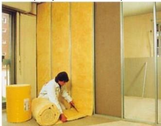
Figura 37 – Aplicação lã de vidro em paredes internas.
