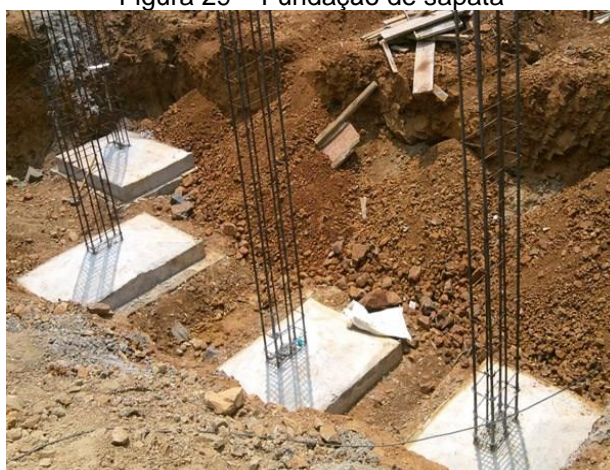
Figura 29 – Fundação de sapata
