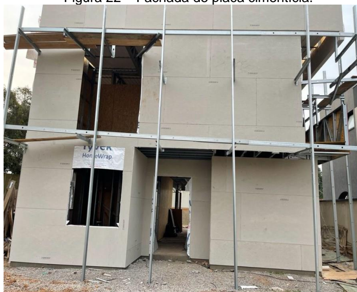
Figura 22 – Fachada de placa cimentícia.
