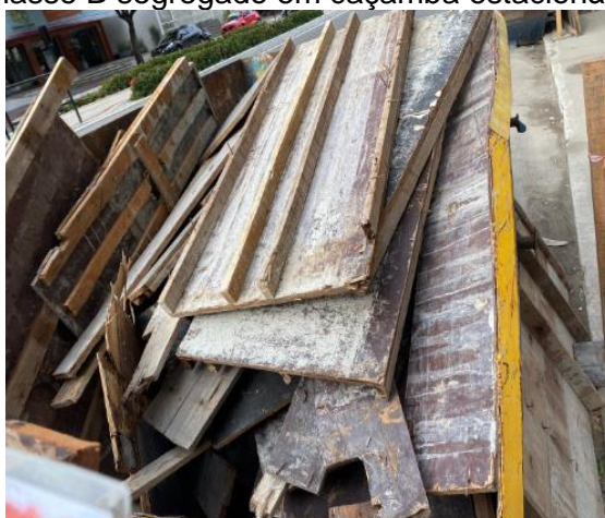
Figura 19 – Resíduo Classe B segregado em caçamba estacionária (madeira) - Obra “C”.
