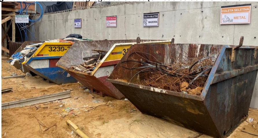
Figura 15 – Resíduos segregados em caçambas estacionárias - Obra “B”.
