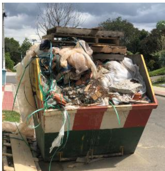
Figura 6 – RCD em caçamba estacionário no condomínio Boulevard Lagoa - Serra/ES.
