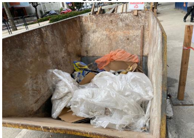
Figura 20 – Resíduo Classe B segregado em caçamba estacionária (plástico e papelão) - Obra “C”.
