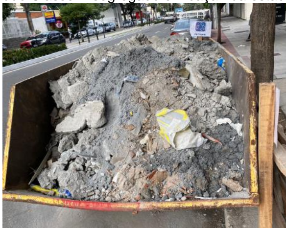
Figura 18 – Resíduo Classe A segregado em caçamba estacionária - Obra “C”.
