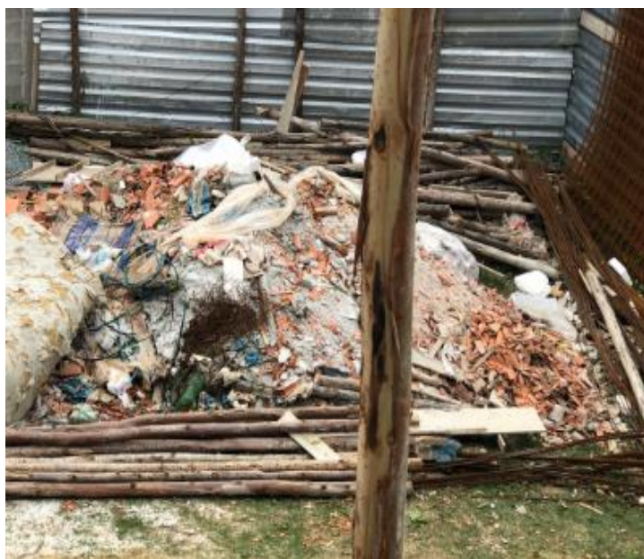
Figura 5 – RCD em canteiros de obras no condomínio Boulevard Lagoa - Serra/ES.
