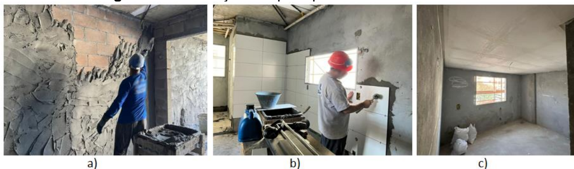
Figura 12 – Execução das principais atividades - Obra “C”.
