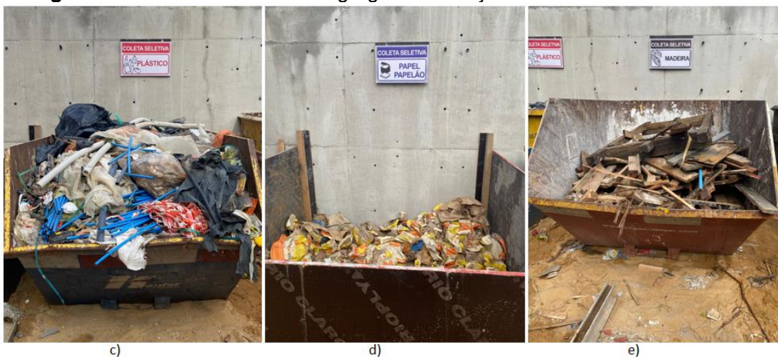
Figura 17 - Resíduo Classe B segregado em caçamba estacionária - Obra “B”.
