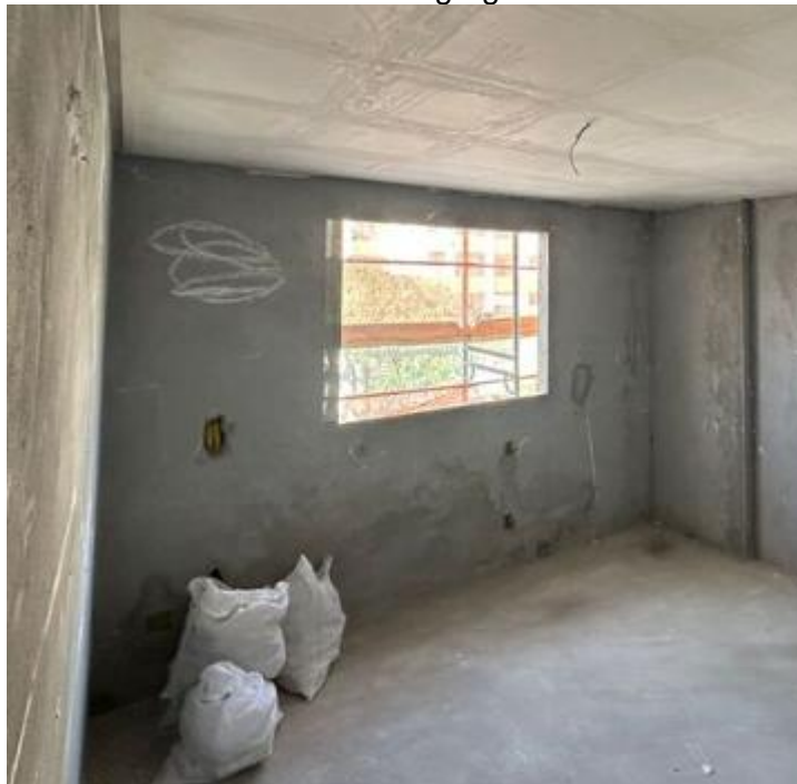
Figura 21 – Resíduo Classe B segregado em sacos - Obra “C”.
