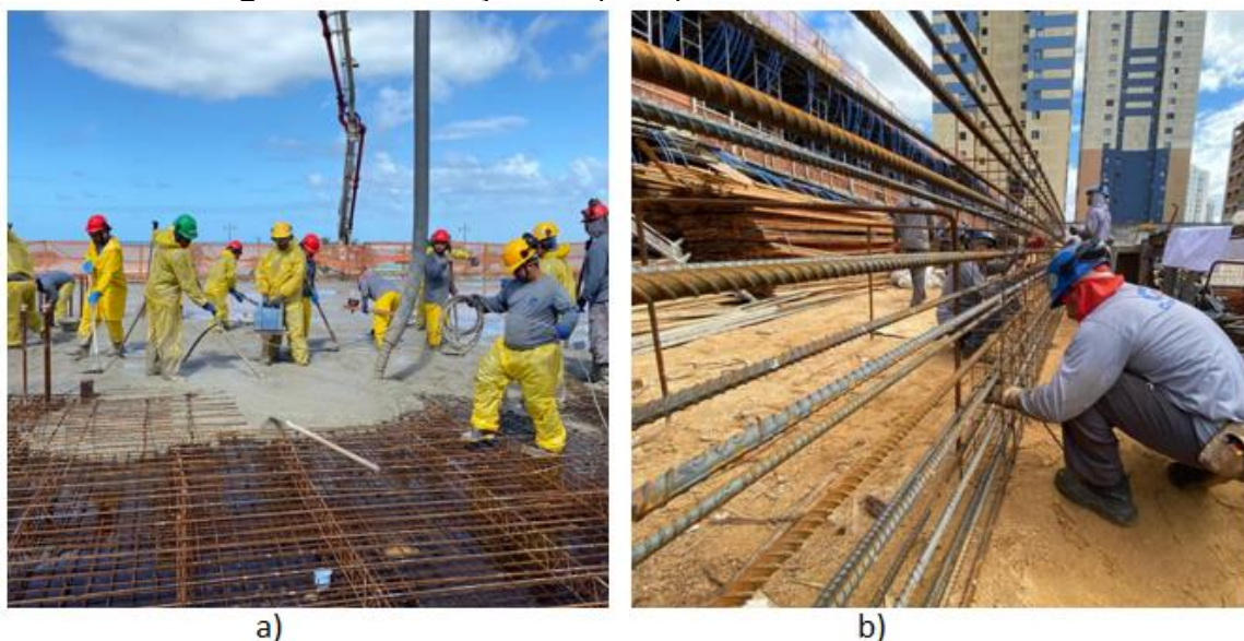
Figura 11 – Execução das principais atividades - Obra “B”.
