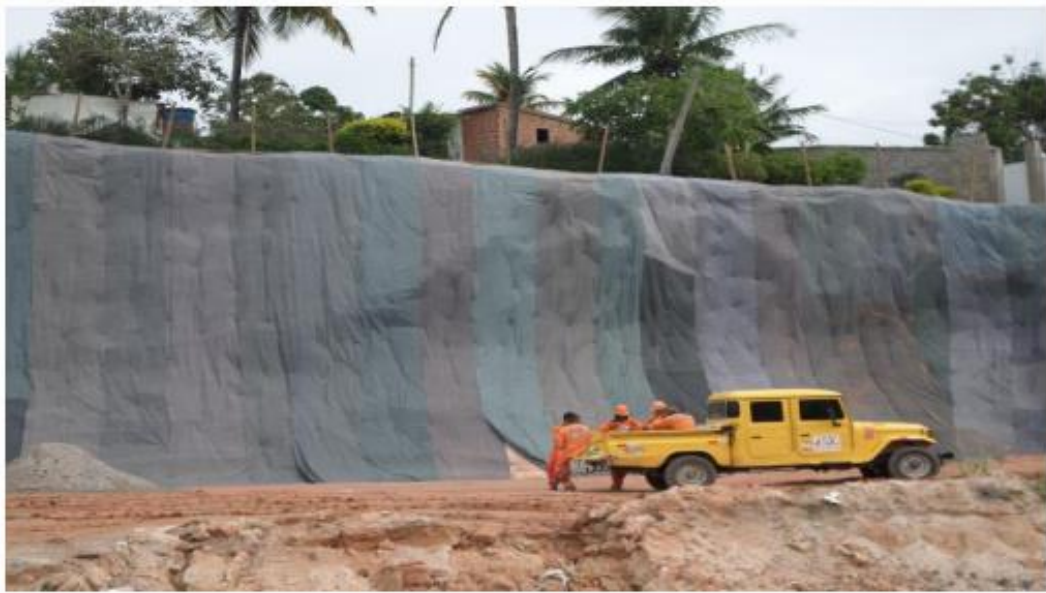
Figura 9 - Proteção de talude com geomanta na Zona Rural de Marataízes – ES – em maio de 2017.
