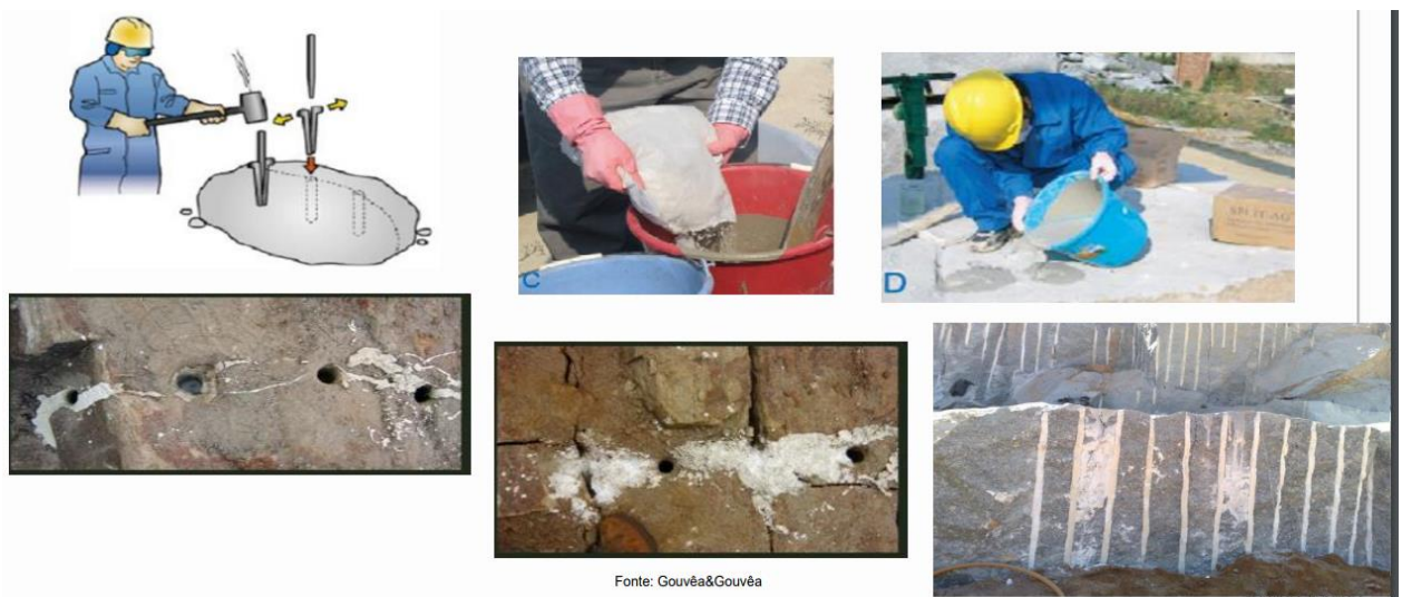
Figura 16 - Exemplificação da utilização de argamassa expansiva
