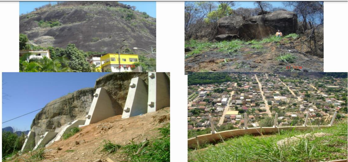
Figura 18 - Estabilização de blocos rochosos Pancas/ES – setembro de 2007
