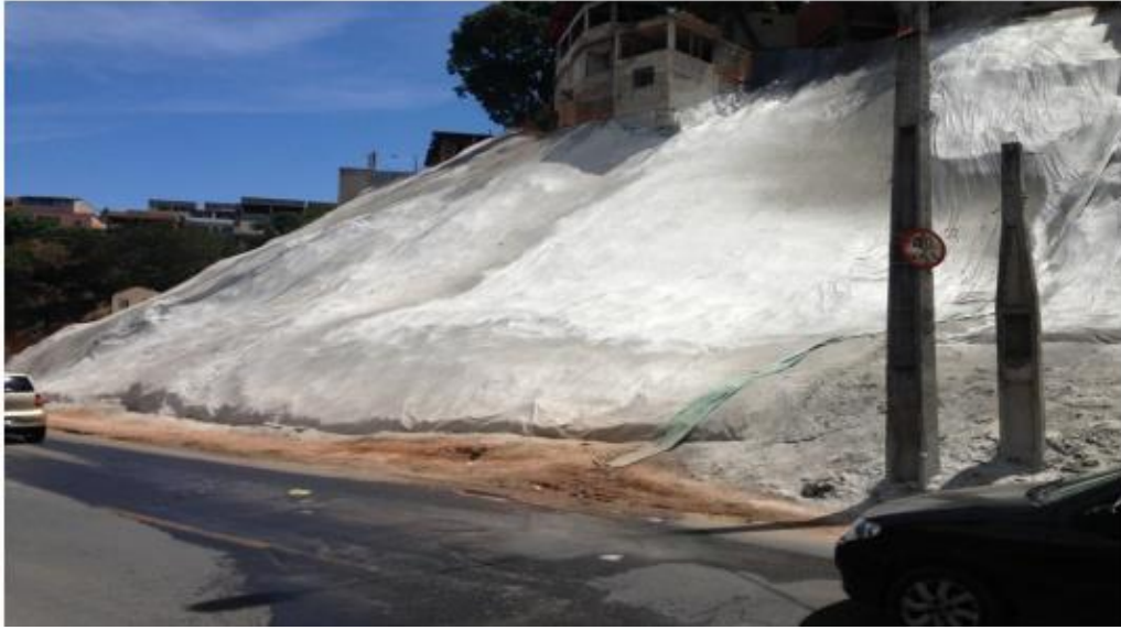
Figura 11 - Proteção de talude com geomanta Bandeirantes - Cariacica – ES – em março de 2015
