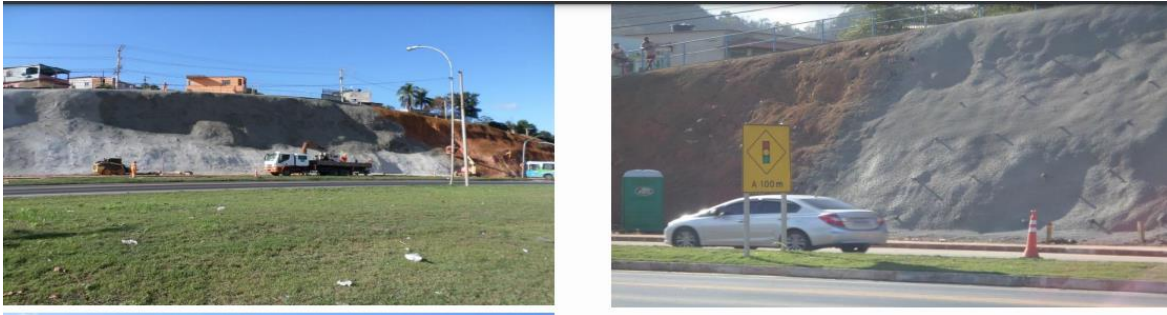
Figura 13 - Concreto projetado Serra/ES – julho de 2016
