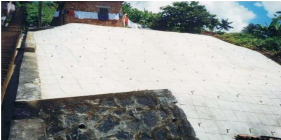
Figura 14 - Revestimento com Tela Argamassada
