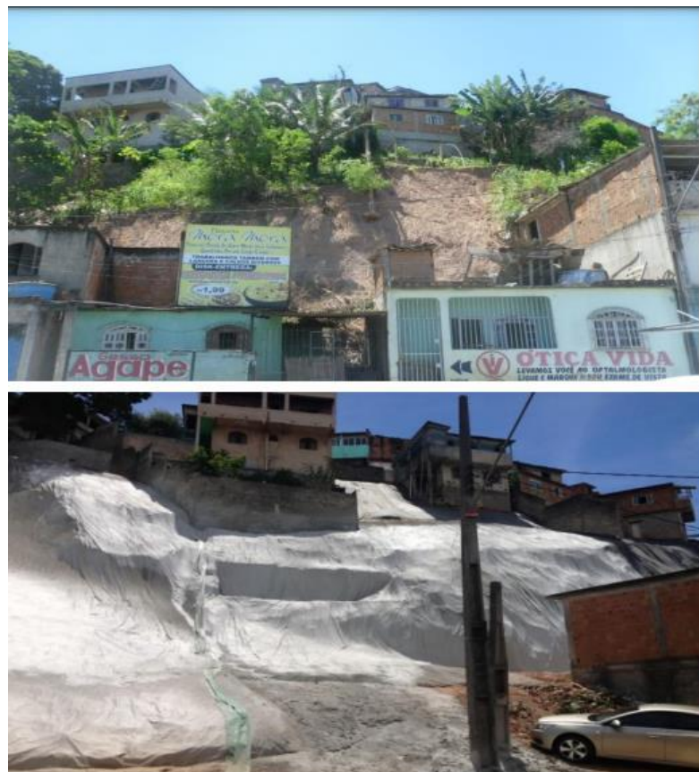
Figura 12 - Proteção de talude com geomanta Bandeirantes - Cariacica – ES – em março de 2015
