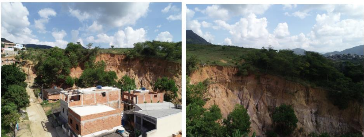
Figura 38 - Vista aérea da encosta em estudo e as residências próximas ao local.
