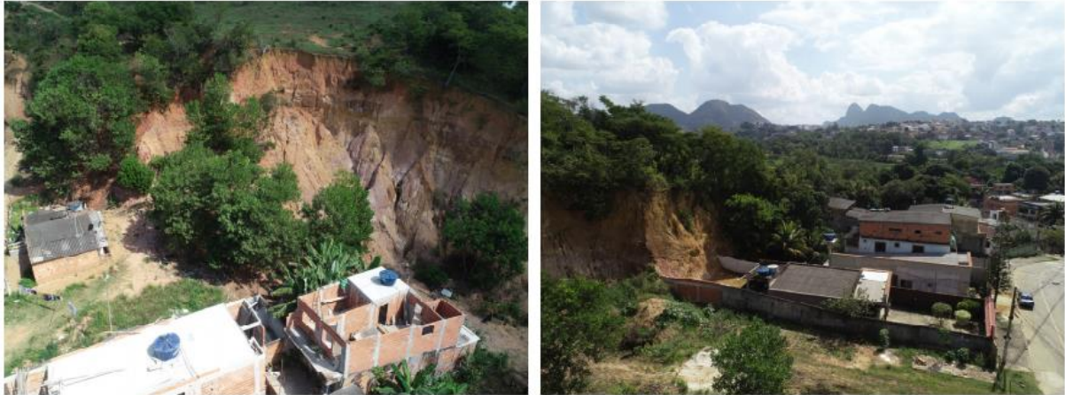
Figura 39 - Vista aérea da encosta em estudo e as residências próximas ao local.
