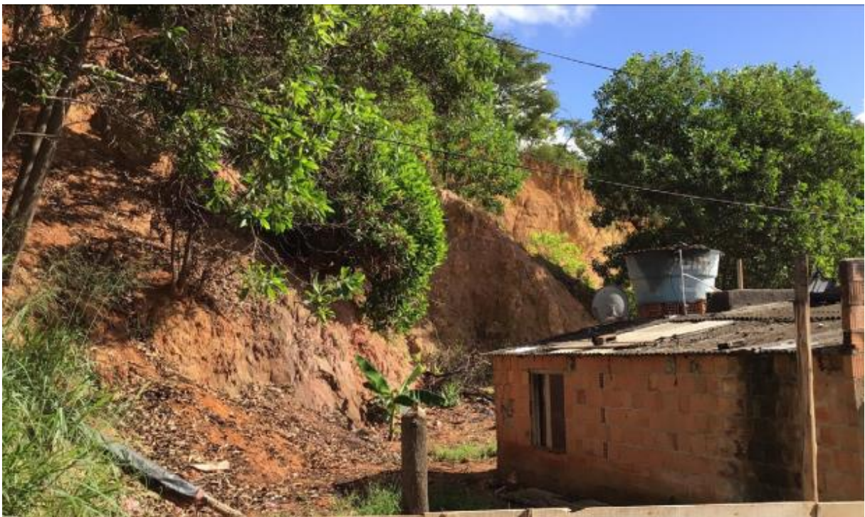
Figura 40 - Vista da encosta e das residências próximas
