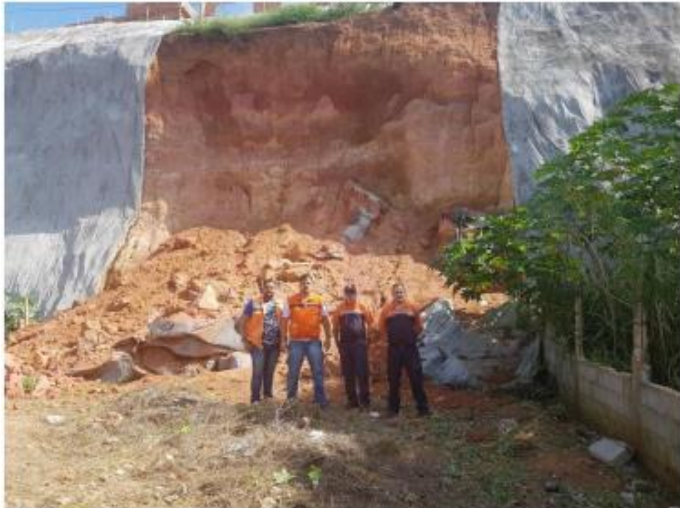
Figura 10 - Proteção de talude com geomanta na Zona Rural de Marataízes – ES – em maio de 2017.
