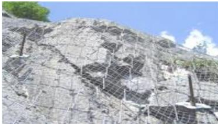
Figura 15 - Proteção de blocos rochosos com tela
