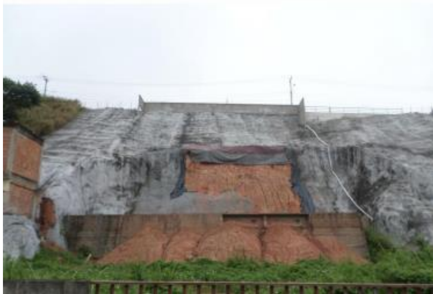
Figura 8 - Proteção de talude com geomanta na Zona Rural de Marataízes – ES – em maio de 2017.
