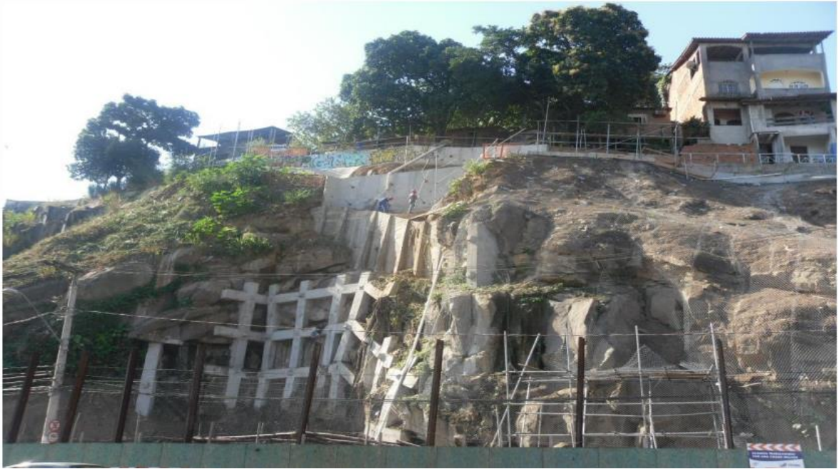
Figura 17 - Estabilização de blocos rochosos Curva do Saldanha – Vitória/ES – maio de 2014
