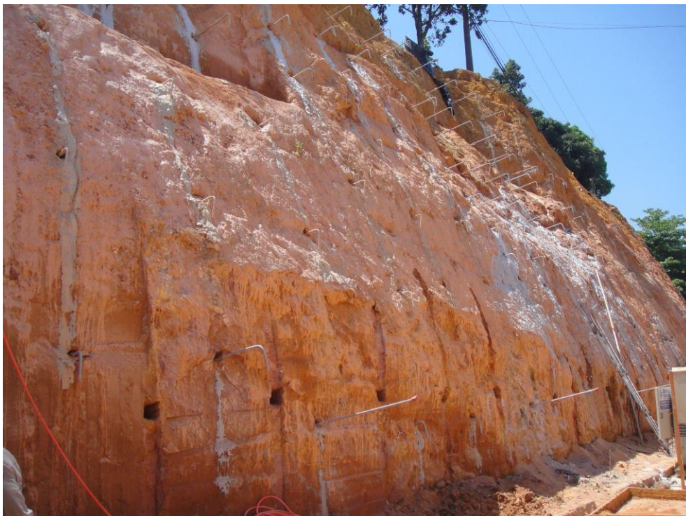
Figura 41: Processo de Grampeamento
