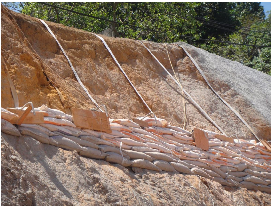
Figura 40: Recomposição do talude com sacos de solo cimento
