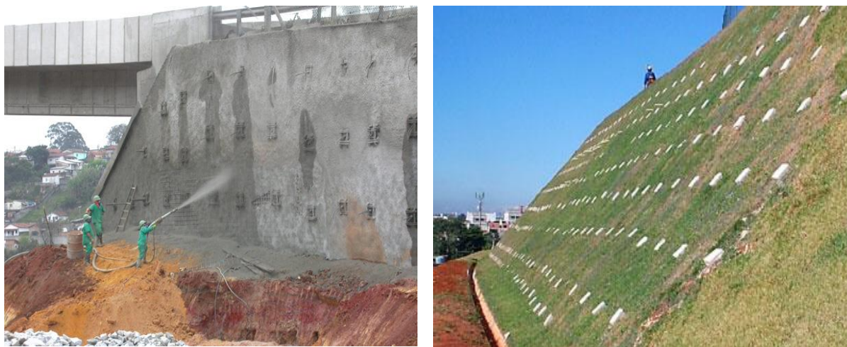
Figura 18: Revestimentos de face de grampeamento
