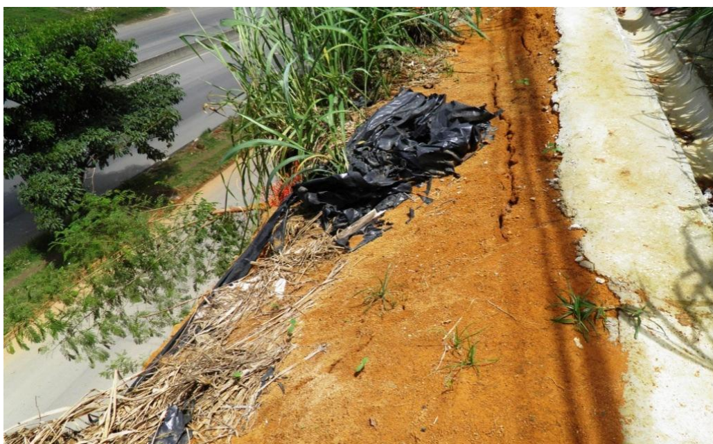
Figura 39: Trincas de tração no topo do talude
