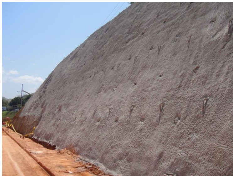
Figura 43: Talude Grampeado
